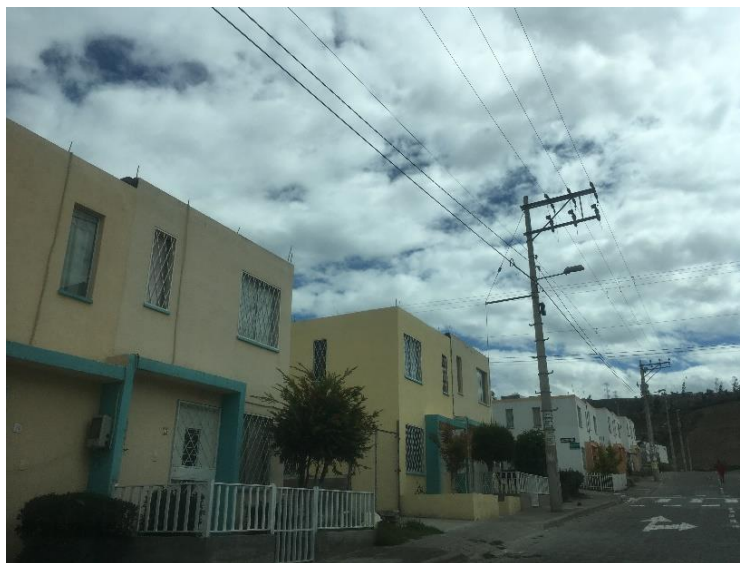
Imagen 40: Ciudad Bicentenario. Cerramientos y apropiación
