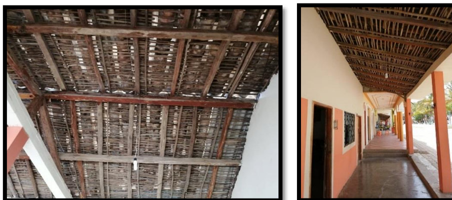
Imagen 47. Materialidad y tipología constructiva de la parroquia Zapotillo
