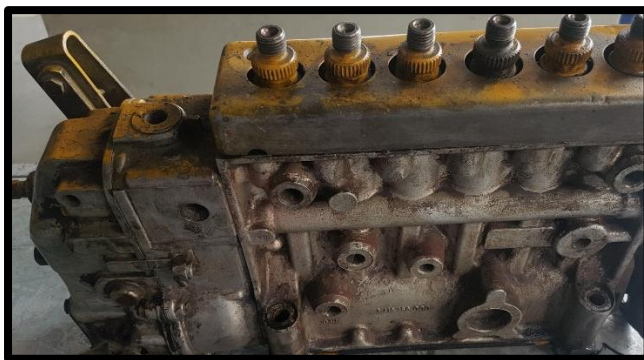
Figura 91. Instalación del regulador de velocidad. (Rodríguez, 2018)
