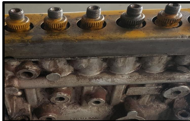
Figura 90. Instalación de los elevadores de los plunger. (Rodríguez, 2018)
