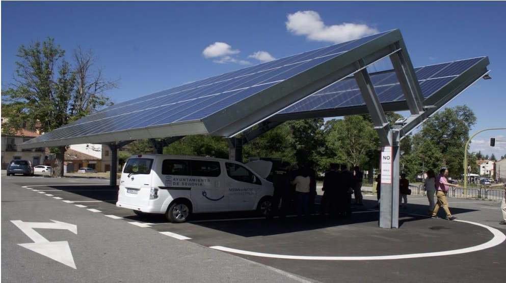
Figura 12. Punto de carga. Electrolineras Fuente: (EcoInventos, 2019)
