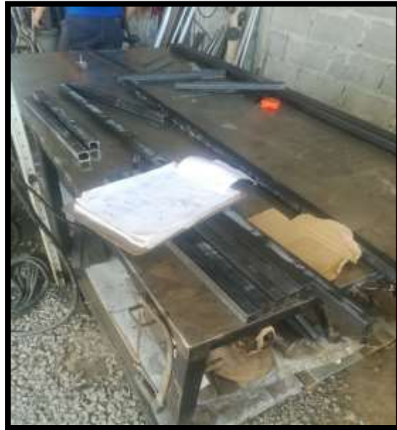
Figura 43. Corte de platinas (Tomalá, 2019)
