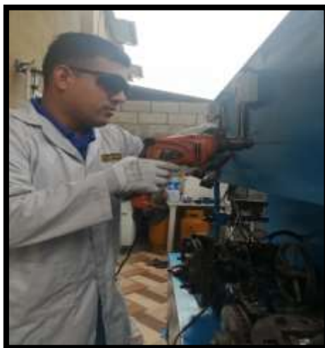
Figura 87. Instalación de conectores de pruebas (Tomalá, 2019)
