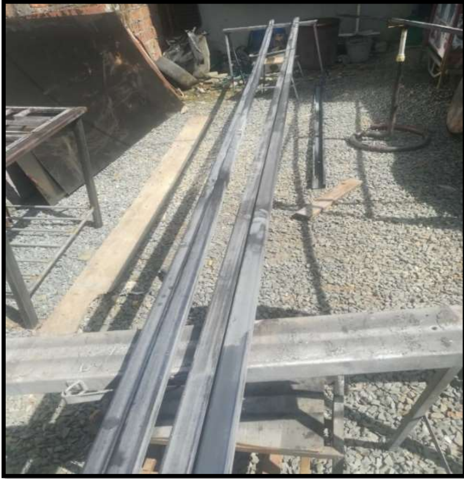
Figura 40. Preparación de materiales (Tomalá, 2019)
