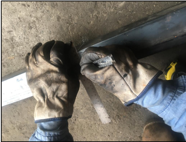
Figura 51. Marcando con escuadra el corte a realizar Fuente. Ángel Paredes
