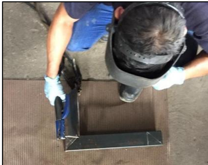
Figura 56. Proceso de ubicación de soldadura Fuente. Ángel Paredes
