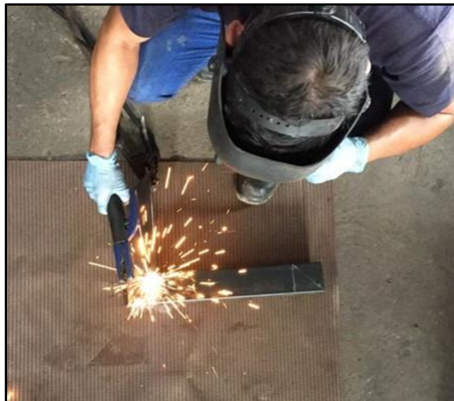
Figura 58. Proceso de cordoneado de soldadura Fuente. Ángel Paredes
