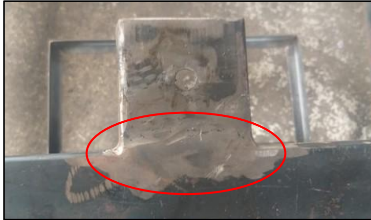
Figura 63. Base con cordón de soldadura ya rectificado Fuente. Ángel Paredes
