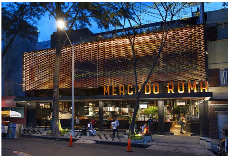
Ilustración 1. Fachada frontal del Mercado Roma
