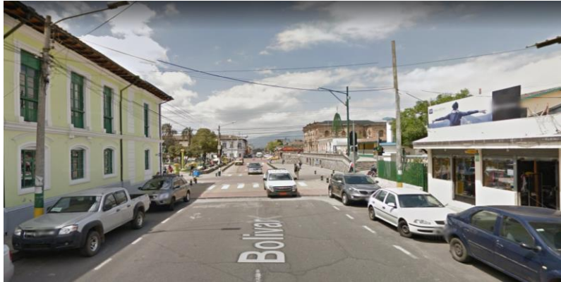
Imagen 136: Imagen del estado actual de la Calle Bolívar Fuente: (Fotografía propia del autor, 2018)
