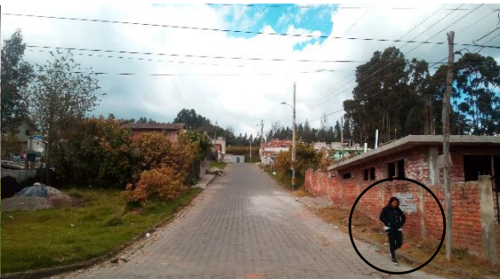
Imagen 127: Veredas en mal estado Fuente: (Fotografía propia del autor, 2018)
