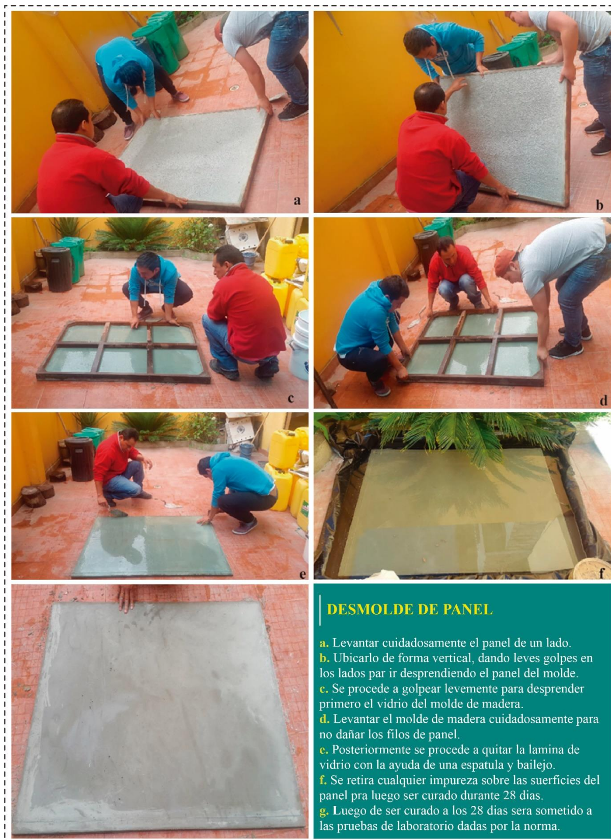
Ilustración. 71. Desmolde de panel
