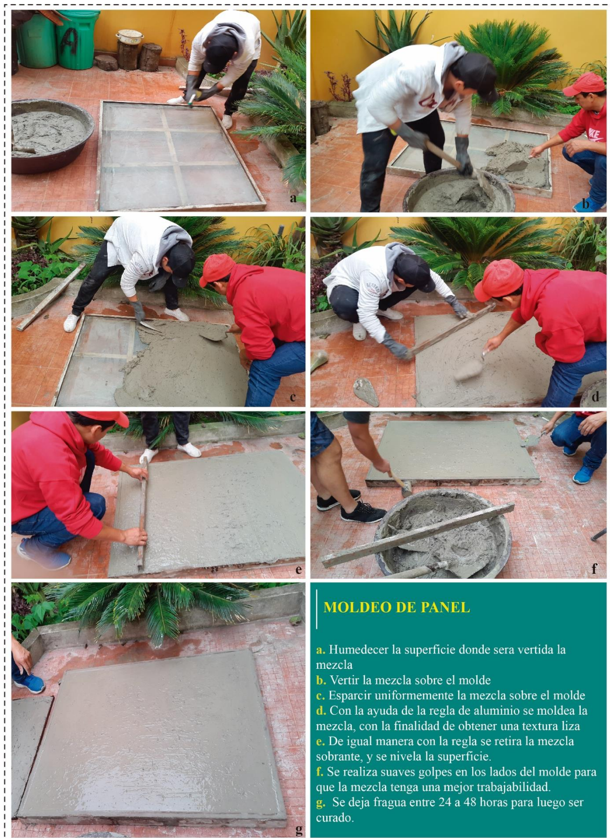
Ilustración. 70. Moldeado del panel
