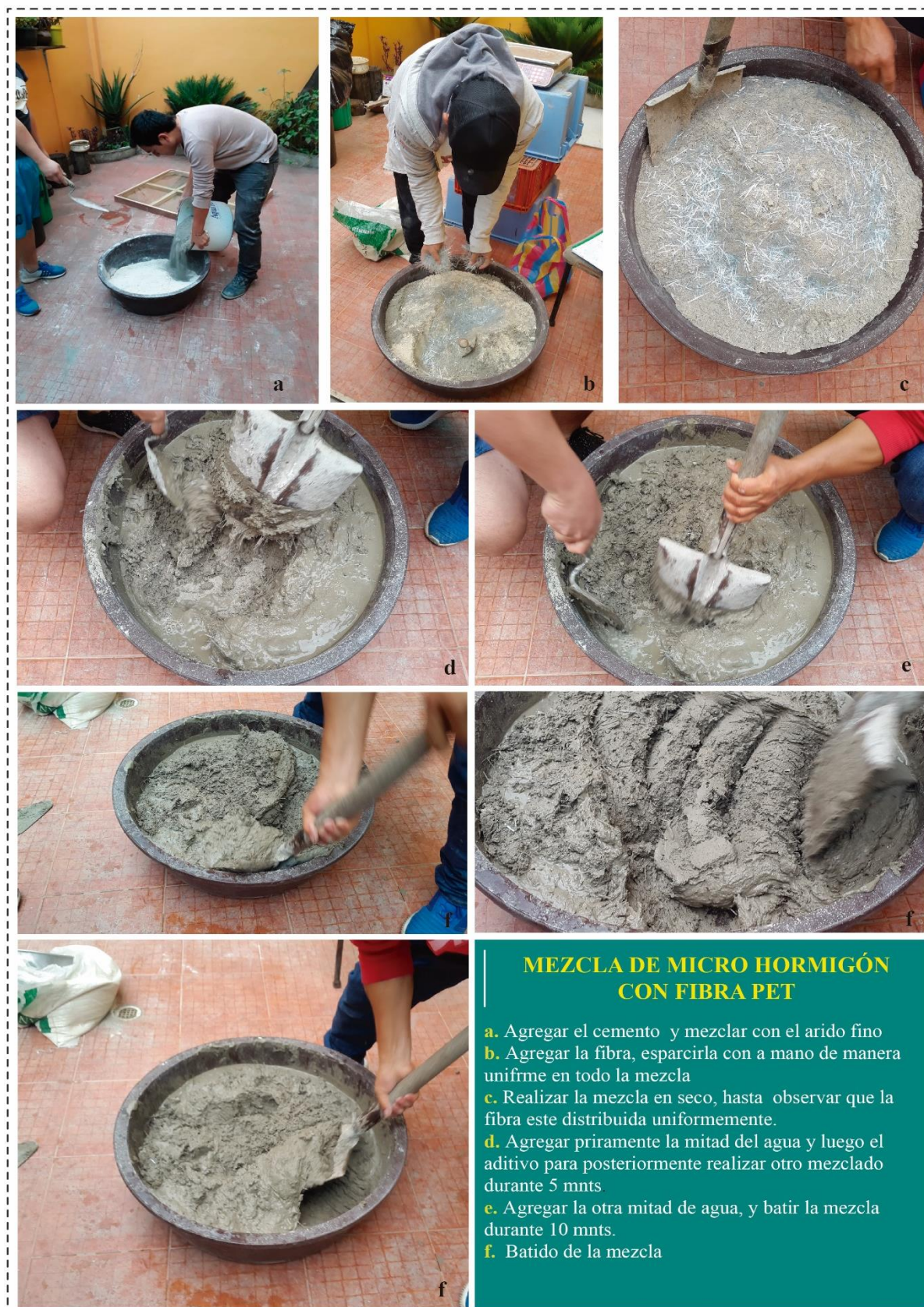
Ilustración. 69. Mezclado de componentes de micro hormigón
