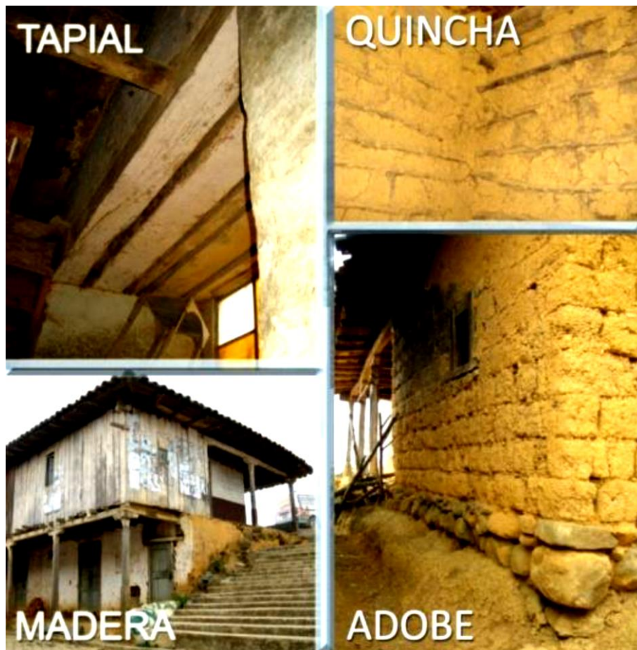
Figura 13. Sistema constructivo de la arquitectura vernácula paltense
