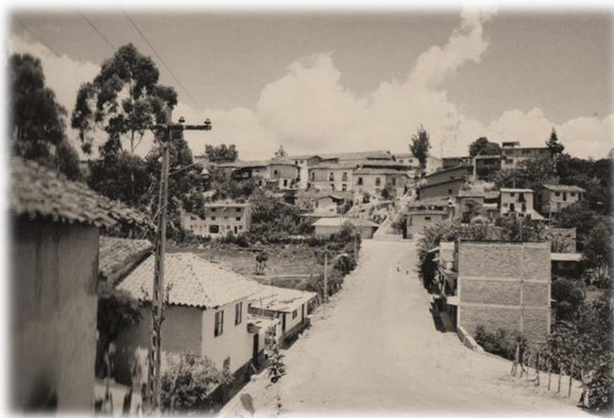
Figura 5. Vista panorámica de Catacocha
