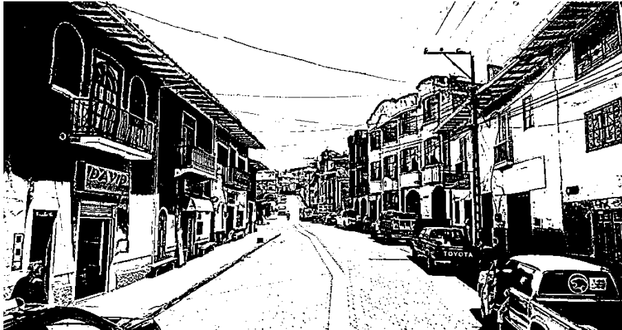
Figura 11. Características del entorno construido
