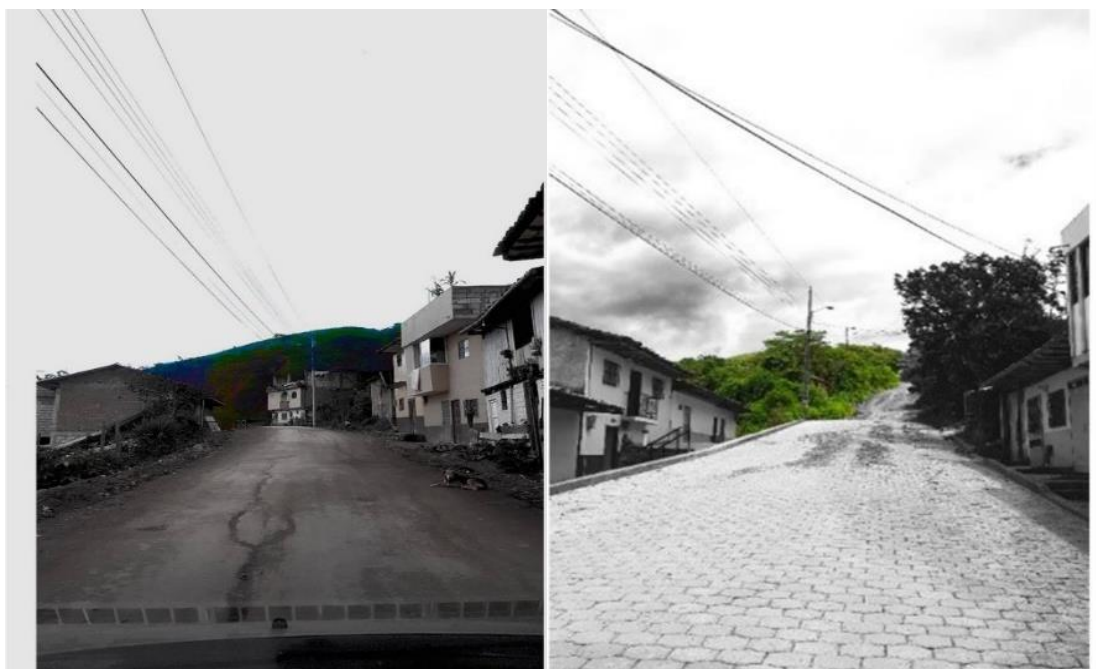
Figura 31. A la izquierda, la vía que conduce a San Vicente del Río. A la derecha, la vía a Huato.
