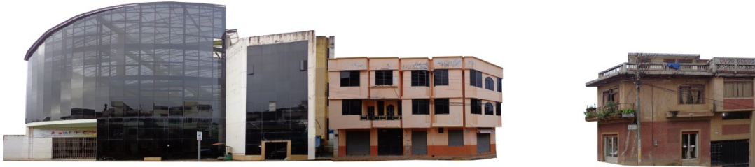
Ilustración 112. Estado actual calle Bernardo Valdivieso
