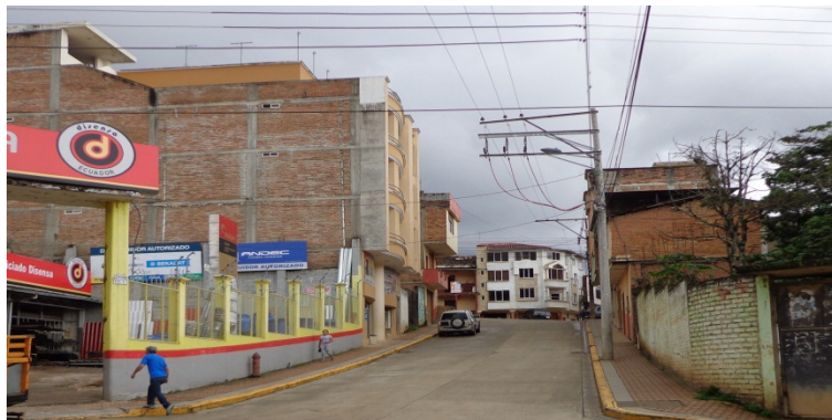
Ilustración 100. Estado actual calle Bernardo Valdivieso
