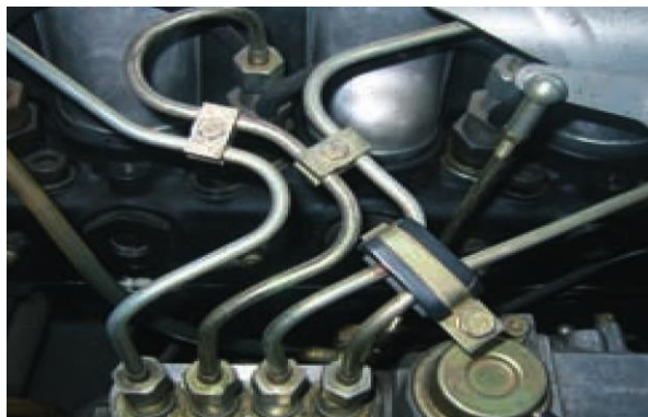
Figura 12 Tuberías de alta presión. (Sánchez, 2013)
