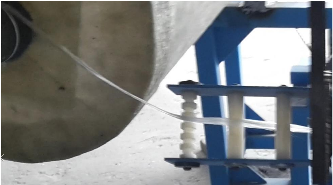
Figura 4.42. Filamento de fibra de vidrio entre la máquina y el molde
