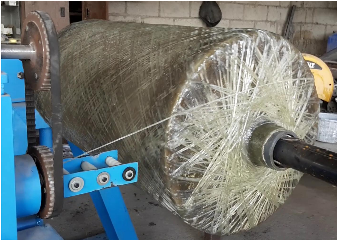
Figura 4.51. Construcción del tanque, tiempo: 2 horas
