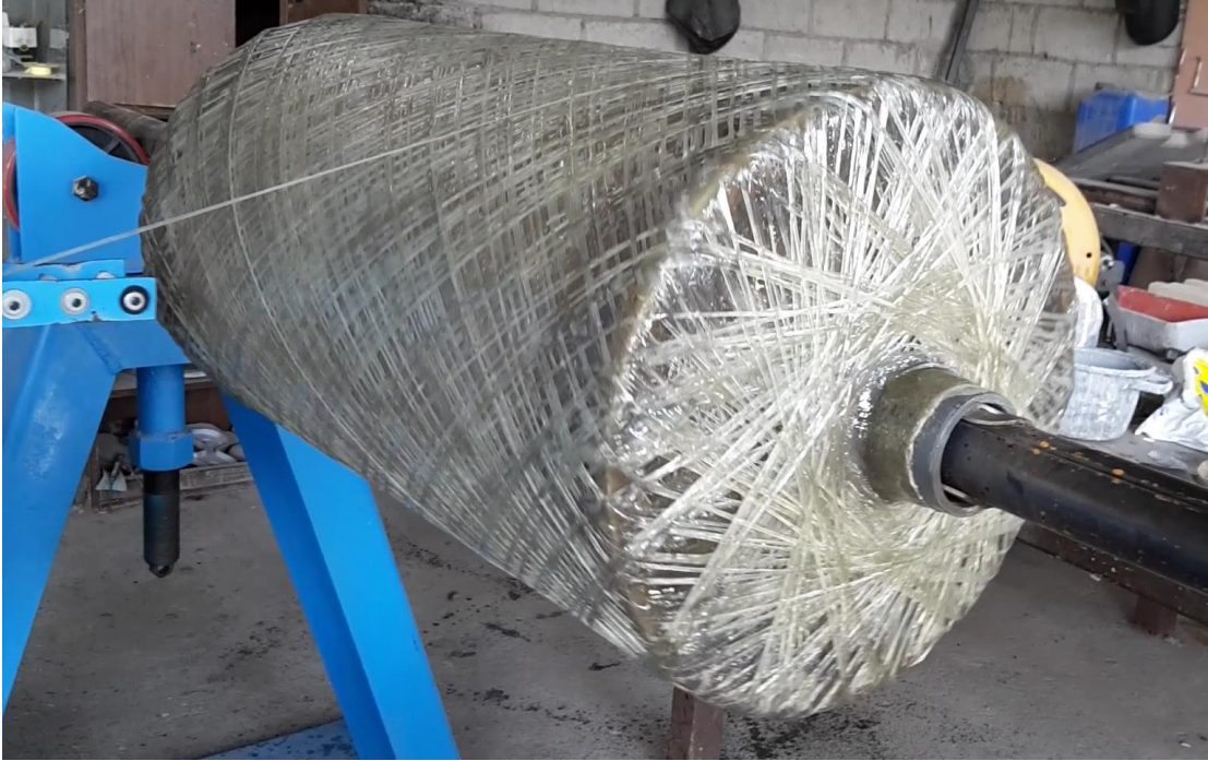
Figura 4.52. Construcción del tanque, tiempo: 3 horas
