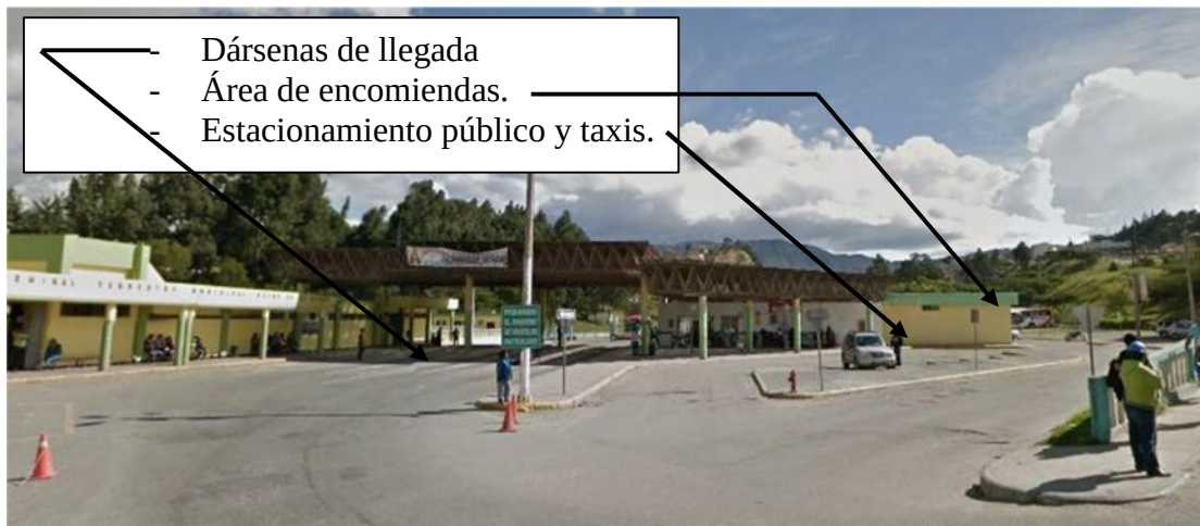
Imagen 10. Dársenas de llegada, estacionamientos y encomiendas
