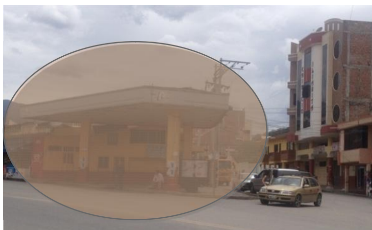
Figura 27. Gasolinera en desuso
