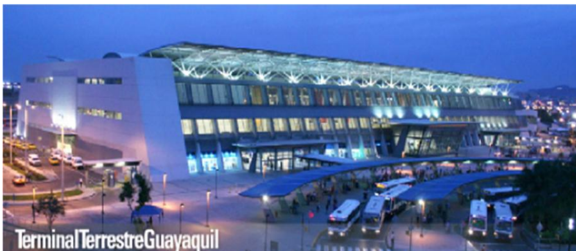
Imagen15. Terminal terrestre de Guayaquil
