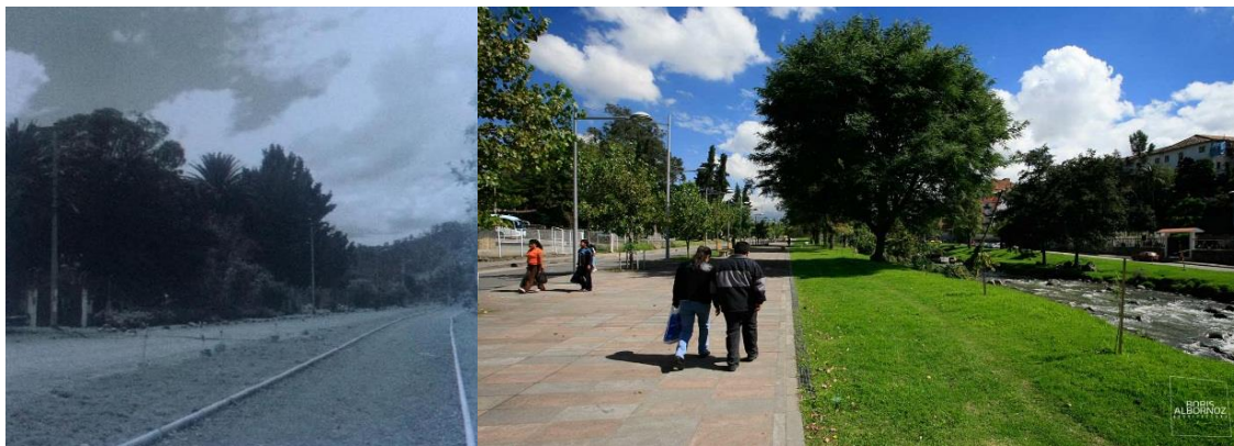
Ilustración 11 Paseo 3 de Noviembre – Tramo 3: izquierda el antiguo tramo, derecha el actual tramo después de la intervención
