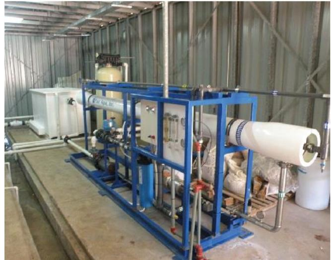
Ilustración 92: Maquinaria para proceso de desalinización del agua. Tomado de <http://www.ecogal.aero/construccion-sustentable>
