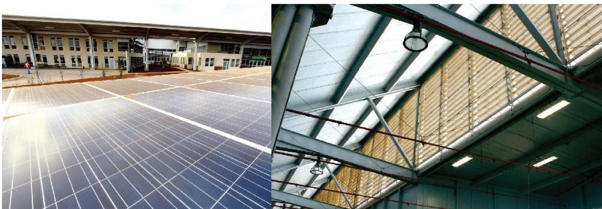
Ilustración 89: Paneles fotovoltaicos y ventilación natural controlada x elementos tipo persianas. Tomado de <http://www.ecogal.aero/construccion-sustentable>
