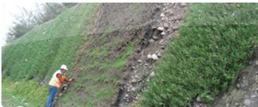
Foto 2. 11: Terraplén en suelo blando
