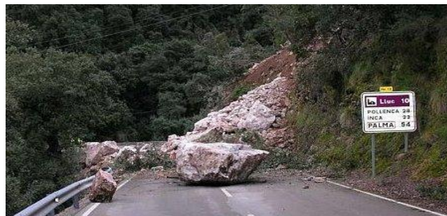
Foto 2. 12: Ejemplo de desprendimiento
