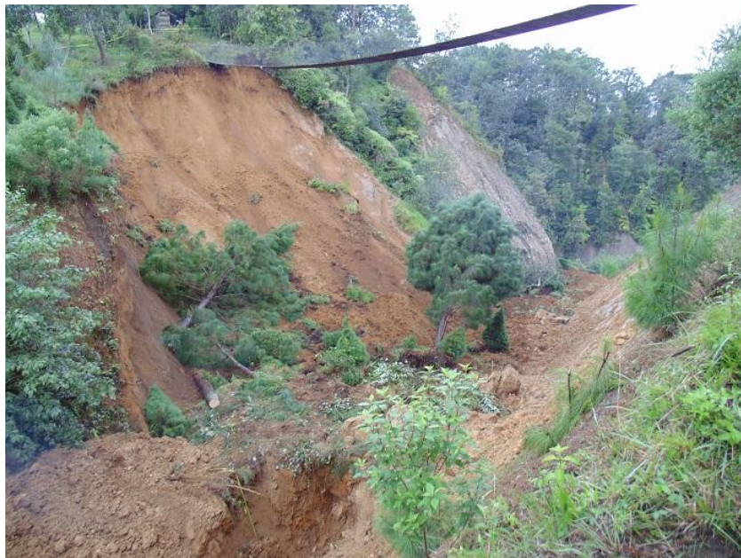
Foto 2. 10. Talud con diferente tipo de material
