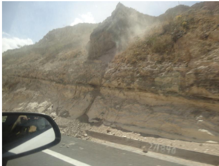
Foto 3. 1: Deslizamiento en el tramo Cochasquí fuente propia.
