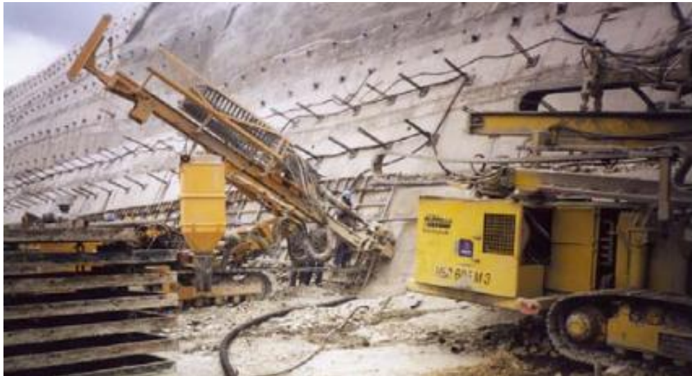
Foto 2. 16.: Ejecución de elementos profundos mediante pantallas o cortinas de pilotes, rectangulares o circulares (pasadores), que tienen la misión de estabilizar el talud alcanzando y atravesando las posibles superficies de rotura, evitando el deslizamiento de la masa de terreno. Estos elementos pueden ir arriostrados en cabeza mediante anclajes perforados en el terreno colaborando para resistir los empujes sobre la cortina de pilotes.
