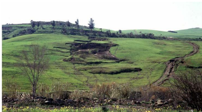
Foto 2. 13. Reptación natural de taludes en “los Destrozos” (Málaga).
