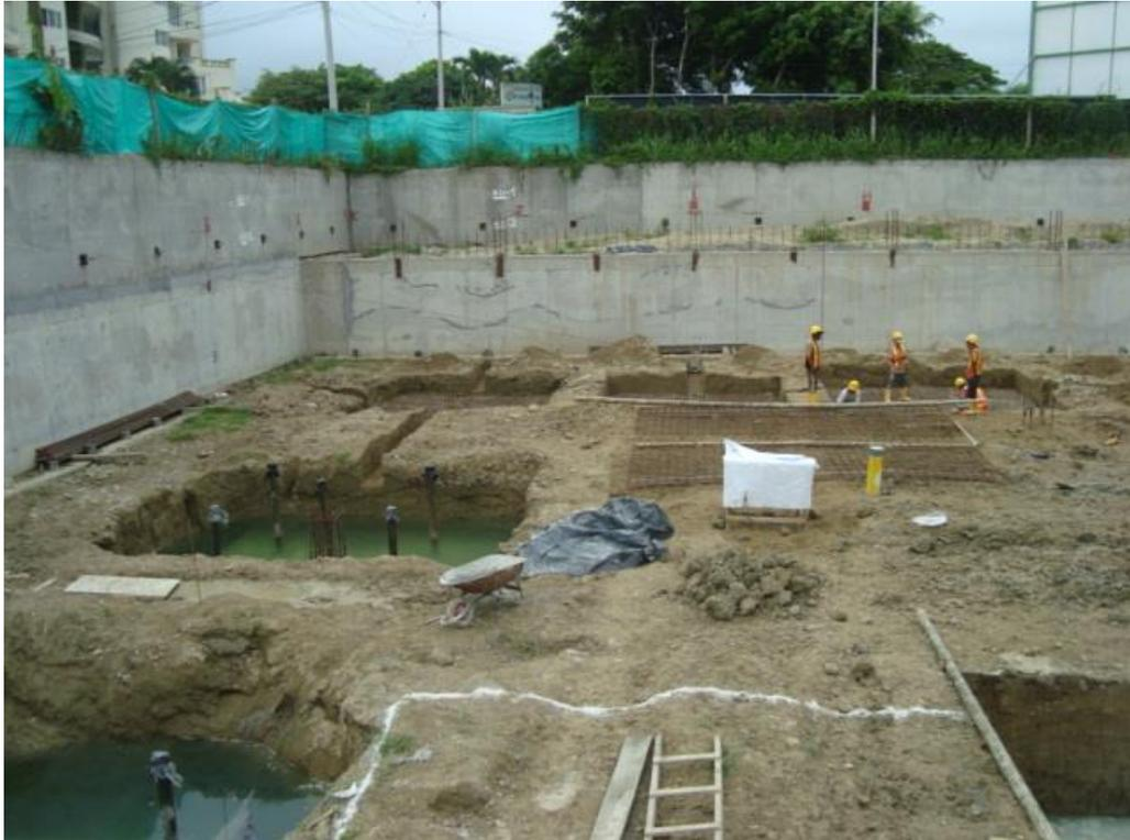
**Ilustración 23. Replanteo de Plintos**
