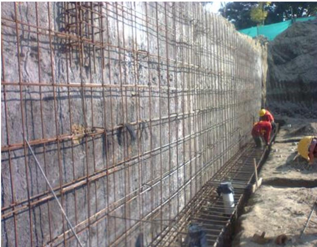
**Ilustración 19. Edificación con Formaleta o Tipo Molde**
