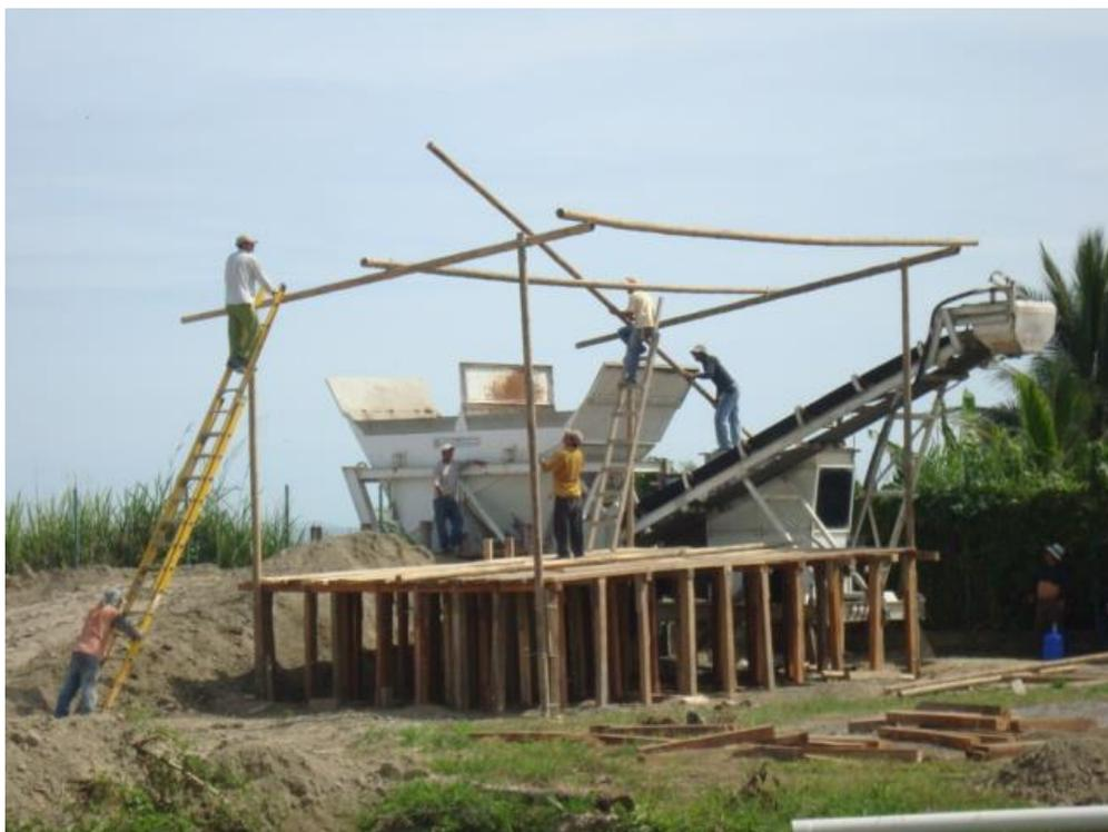
**Ilustración 16.** Construcción de la plataforma de la planta de hormigón
