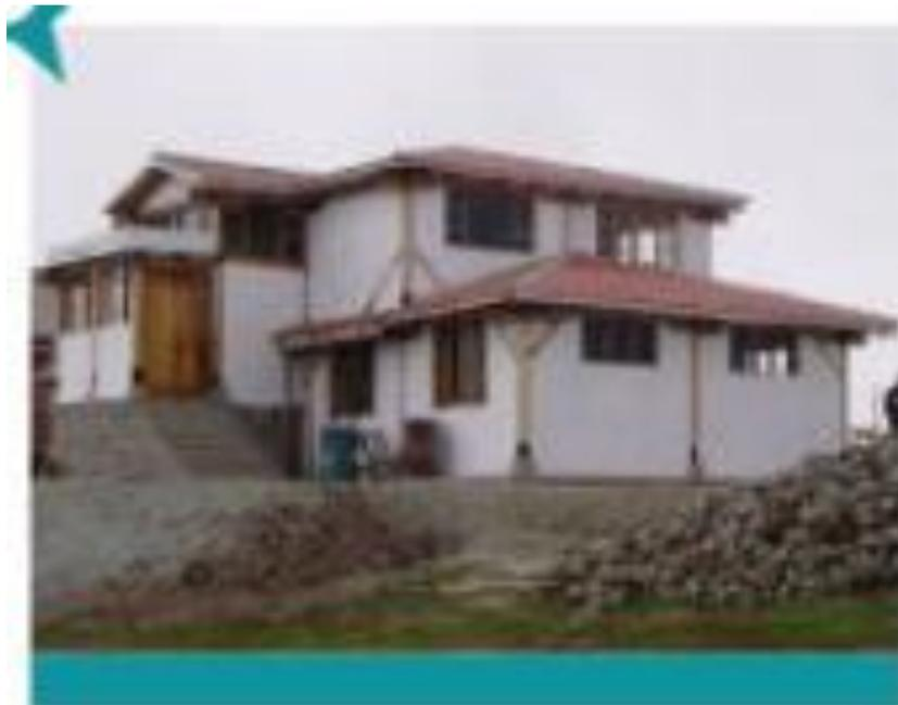
**Ilustración 10. Edificación Mixta Ladrillo y Madera**
