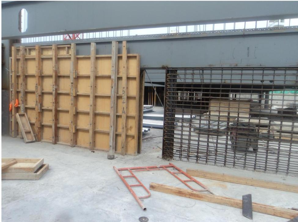
**Ilustración 52. Colocación de acero y encofrado de diafragmas**
