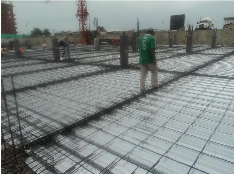
**Ilustración 49. Colocación del acero de refuerzo en losa**
