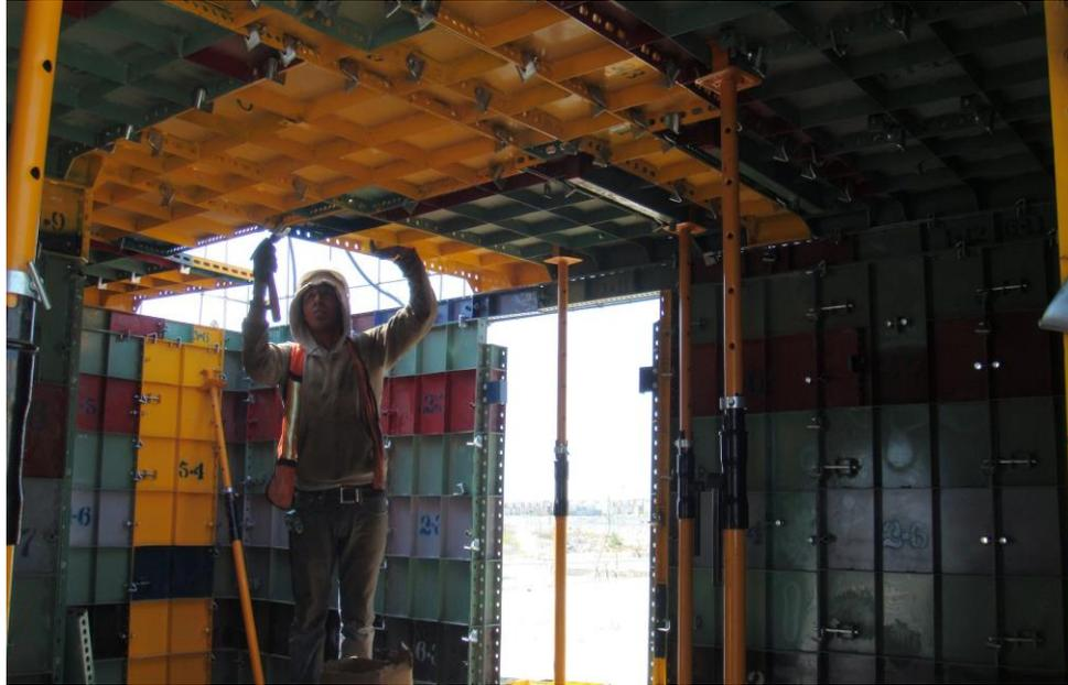
**Ilustración 14. Edificación con Formaleta o Tipo Molde**
