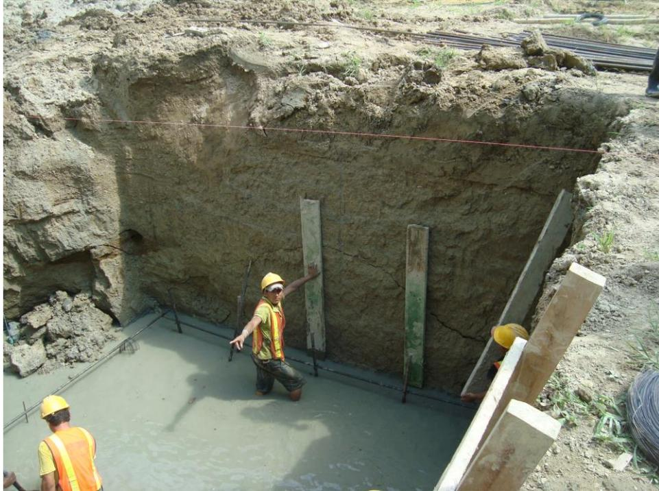
**Ilustración 26. Entibado de paredes de plintos**
