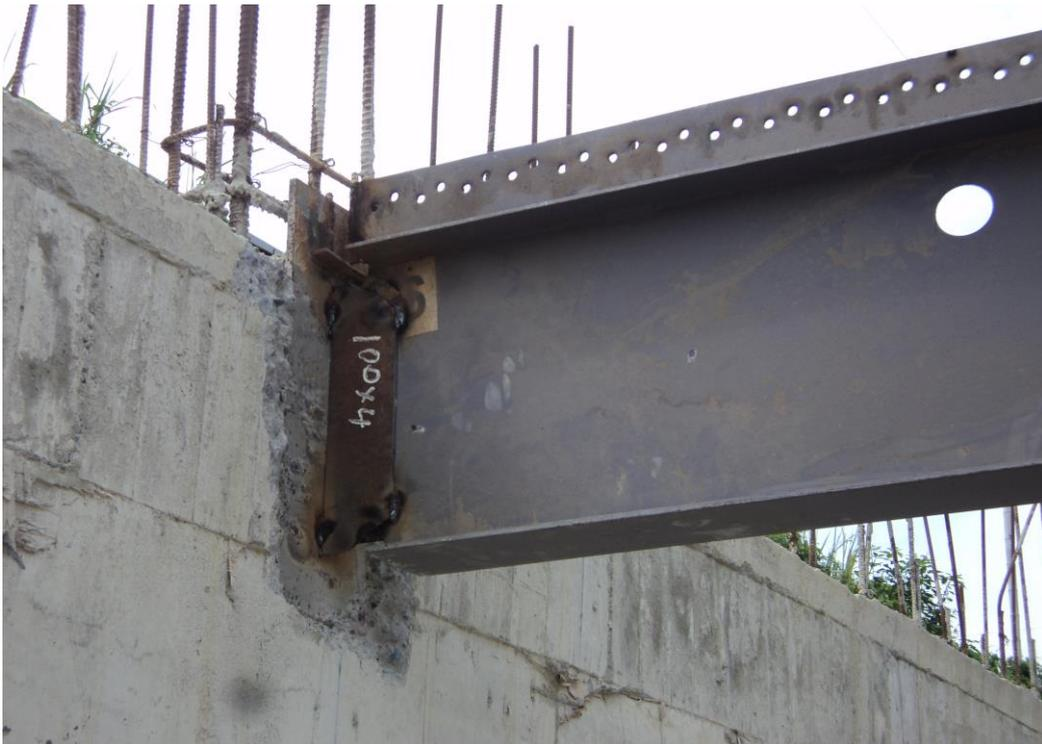
**Ilustración 39. Montaje de Vigas**
