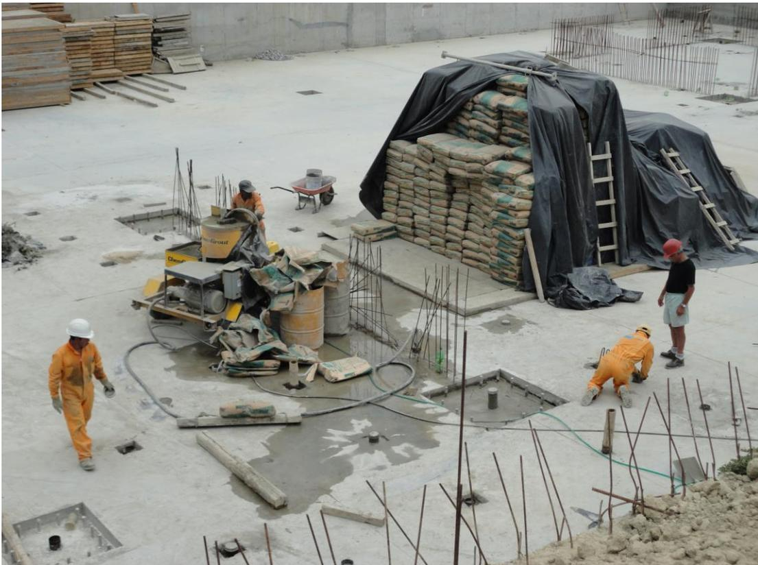
**Ilustración 35. Mejoramiento de suelo con inyecciones**
