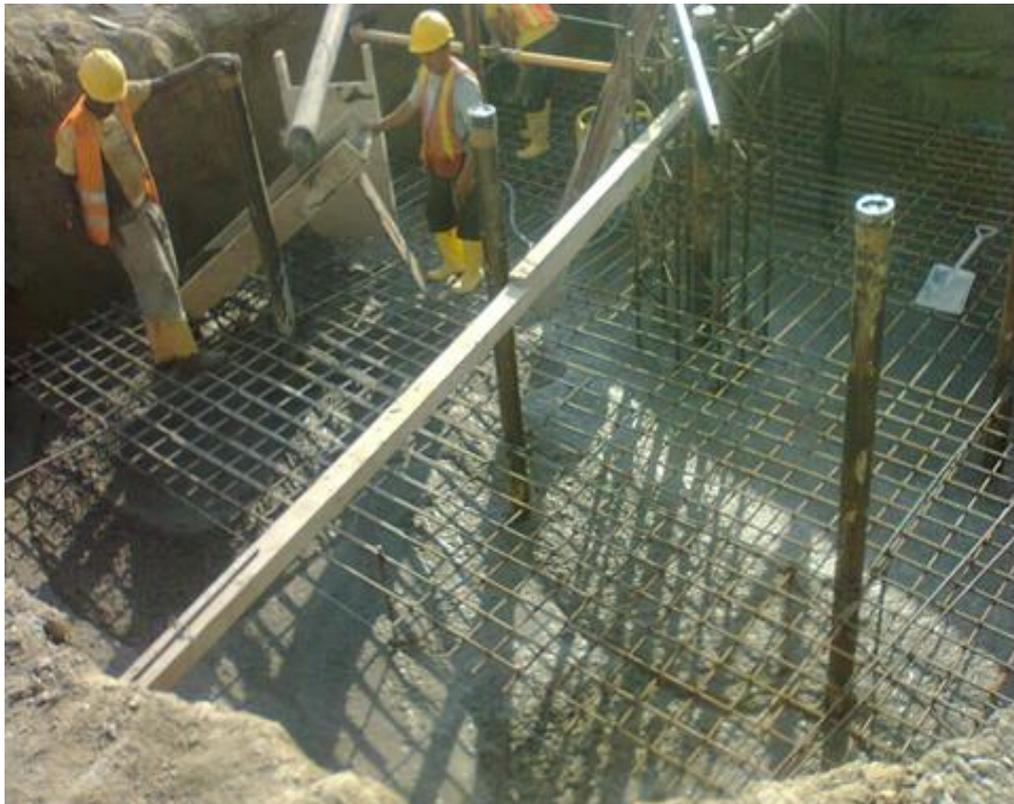
**Ilustración 28. Fundición de Plintos**
