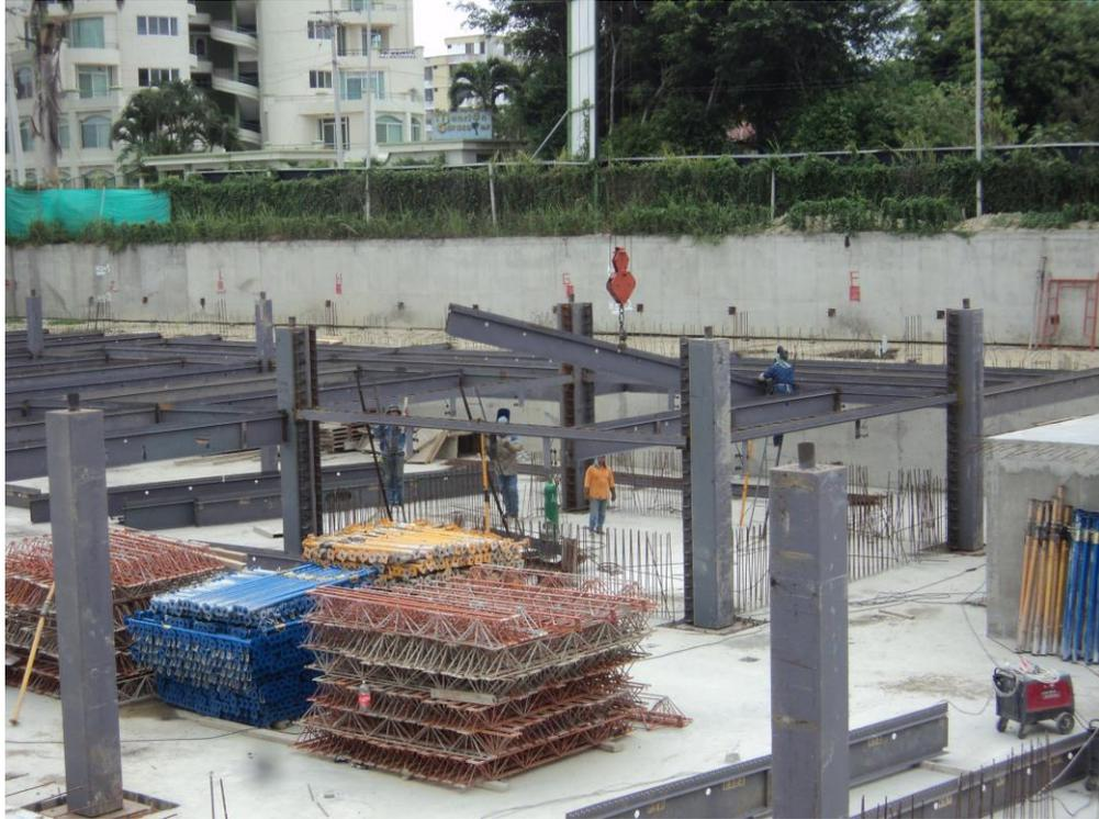
**Ilustración 38. Montaje de Vigas**
