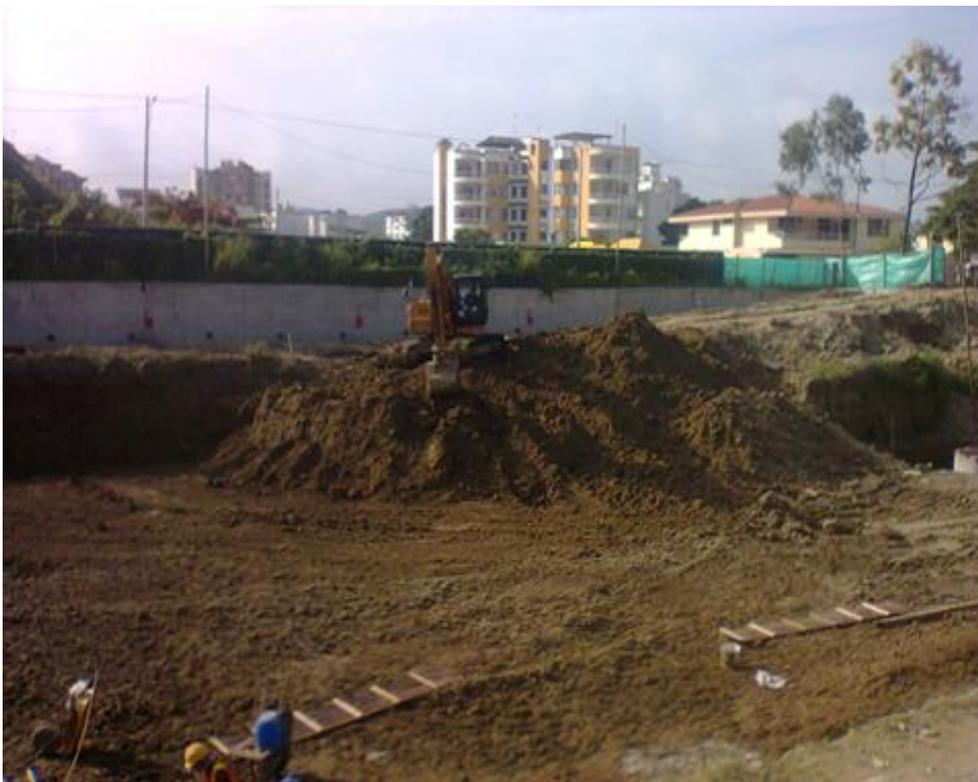
**Ilustración 17. Excavación a máquina**
