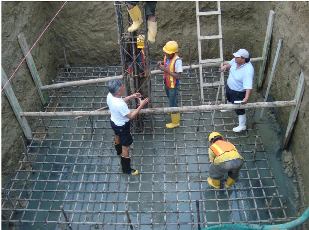
**Ilustración 27. Colocación del acero de refuerzo en plintos y canastillas**
