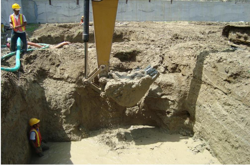
**Ilustración 24. Excavación a máquina de plintos**
