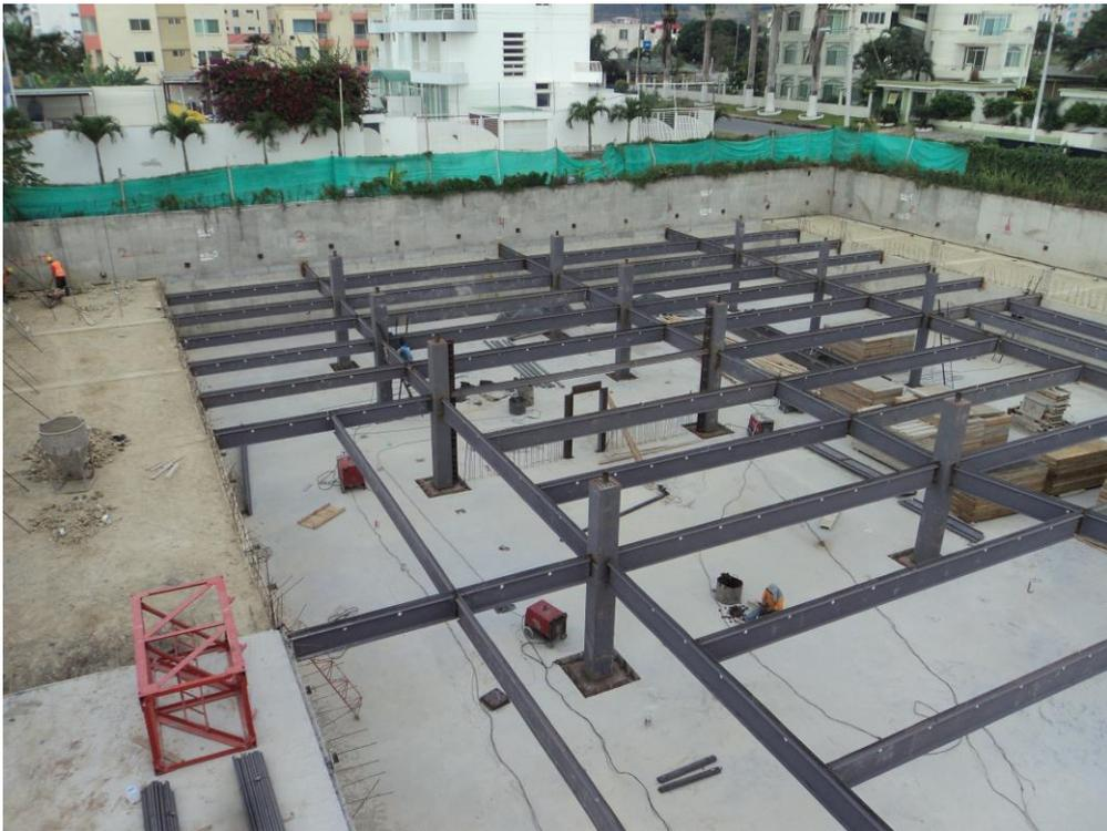
**Ilustración 42. Montaje de estructura del subsuelo 2**
