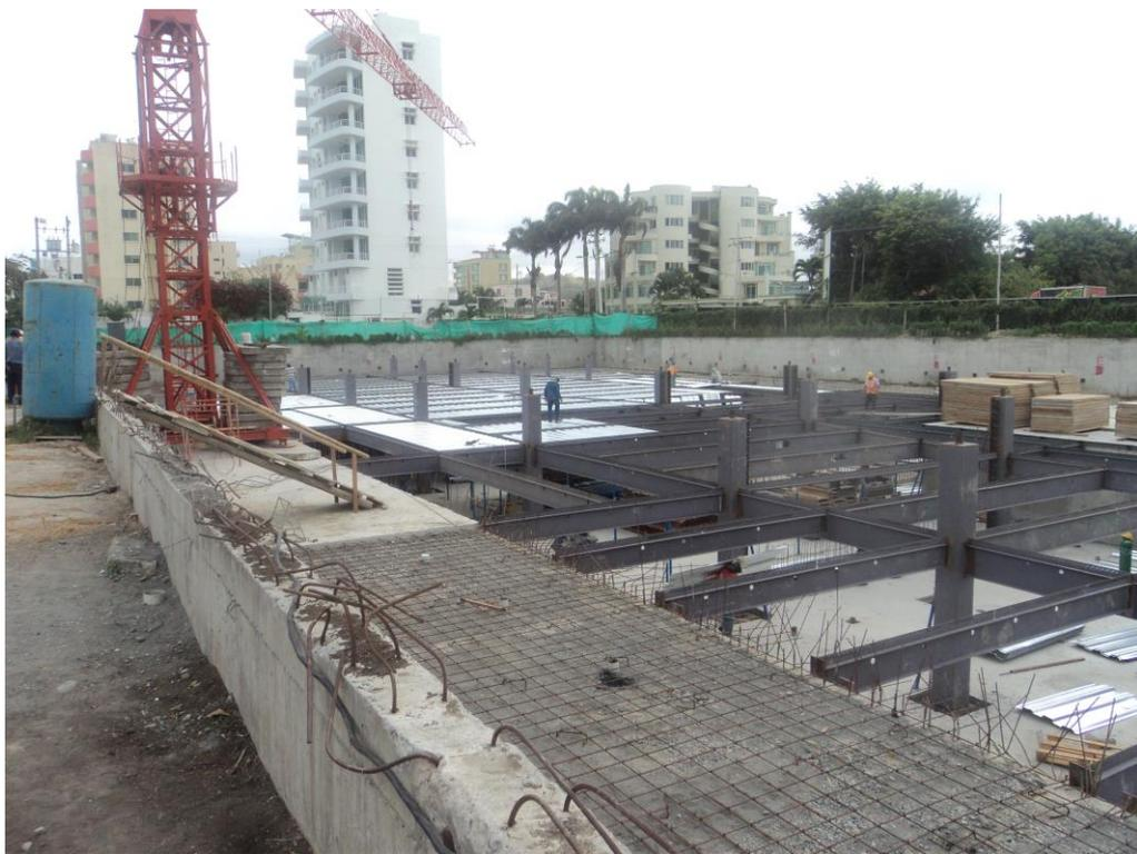
**Ilustración 43. Instalación de deck**
