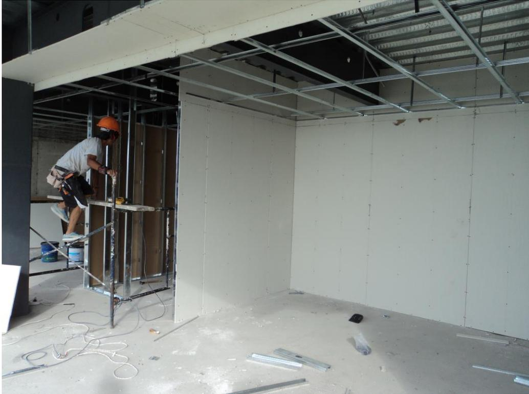
**Ilustración 56. Instalación de planchas de gypsum**
