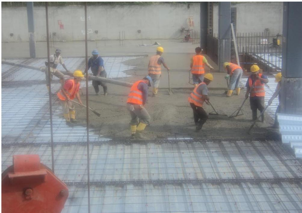
**Ilustración 50. Fundición de losa**
