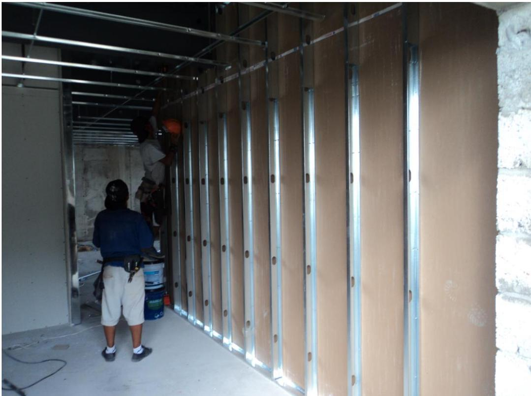
**Ilustración 55. Paredes y tumbados en gypsum**
