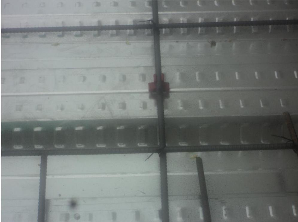
**Ilustración 48. Alzas de acero en la losa**
