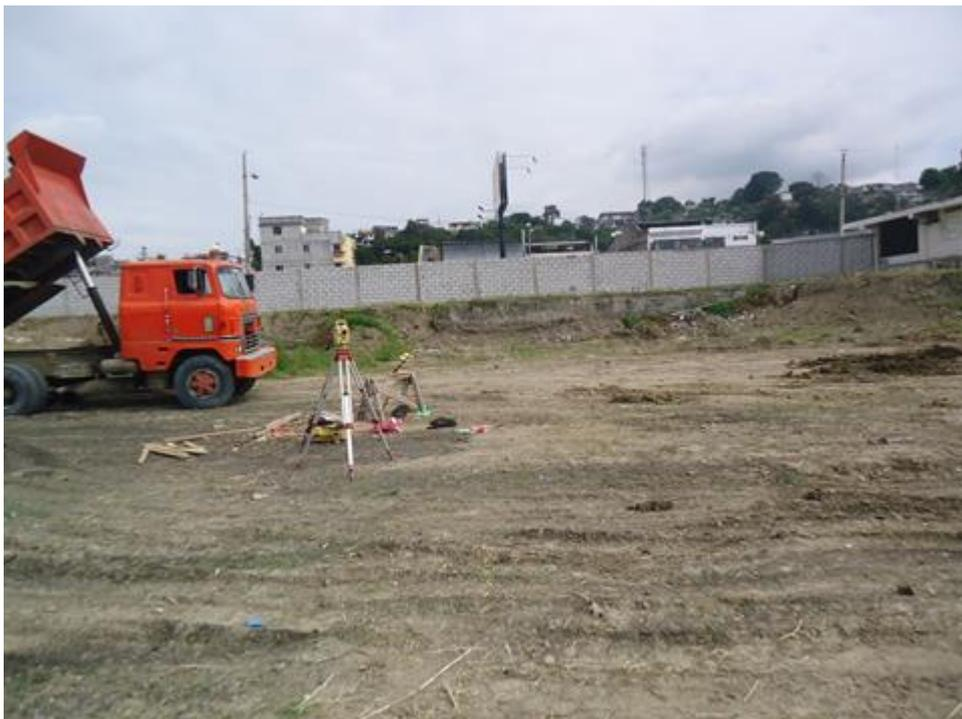
**Ilustración 15. Replanteo y Nivelación**
