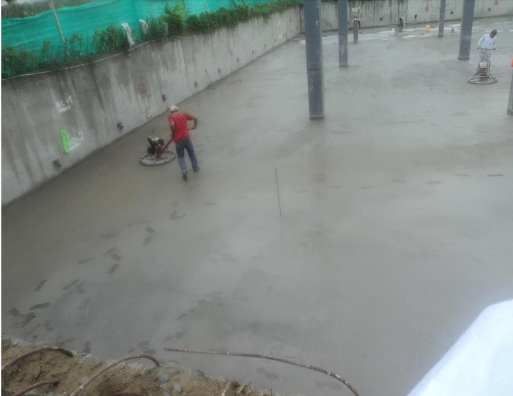
**Ilustración 51. Alisado de losa**
