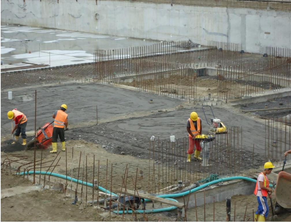
**Ilustración 32. Relleno Compactado**
