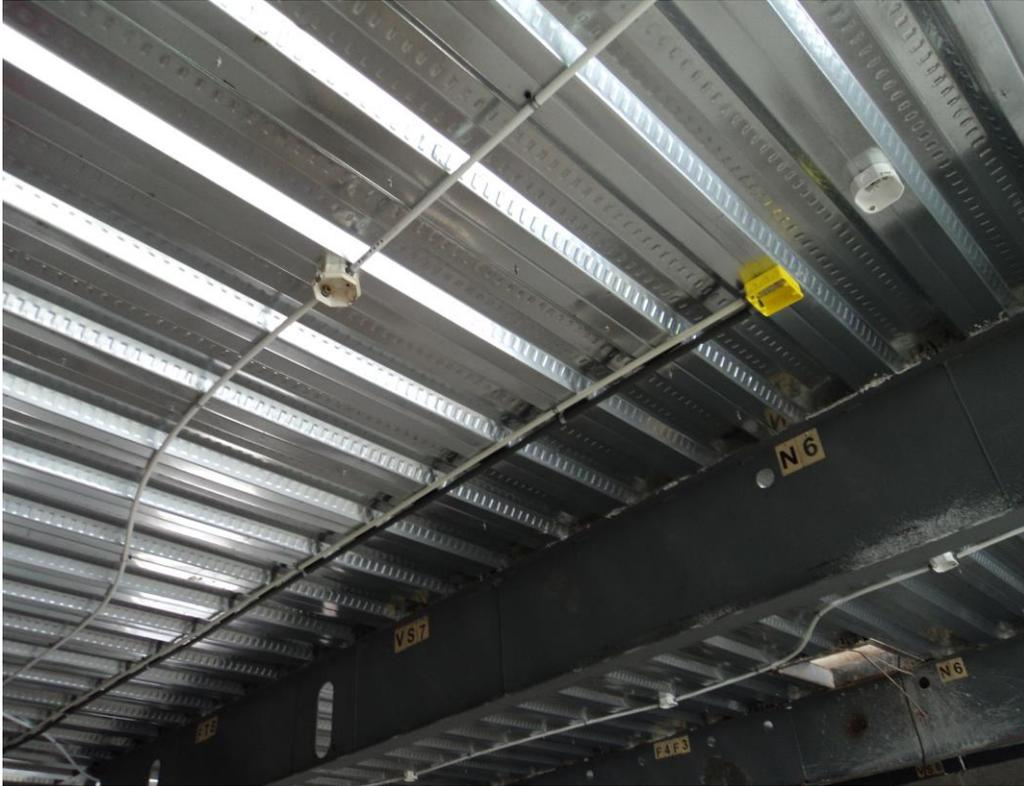
**Ilustración 57. Instalación de tuberías eléctricas**
