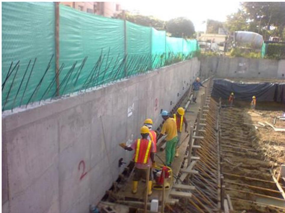
**Ilustración 21. Fundición de Muros Perimetrales**
