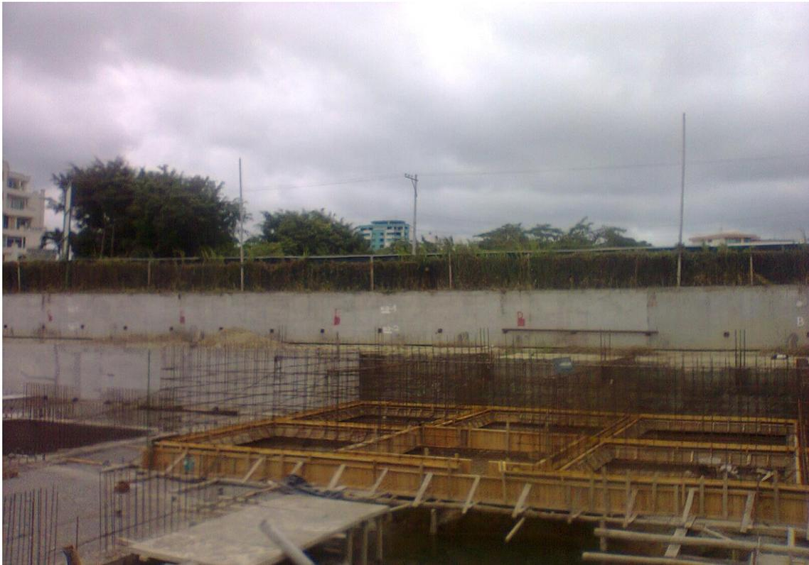
**Ilustración 58. Construcción de Cisternas**
