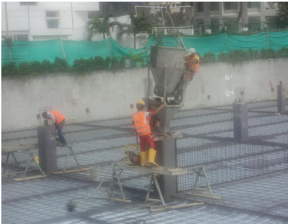
**Ilustración 46. Fundición de columnas**
