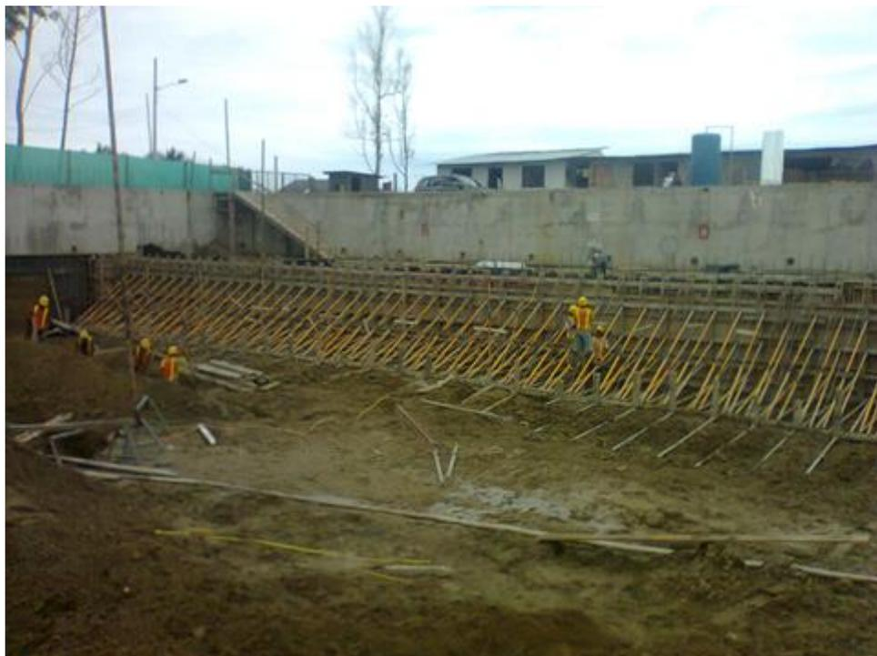
**Ilustración 20. Encofrado de Muros Perimetrales**
