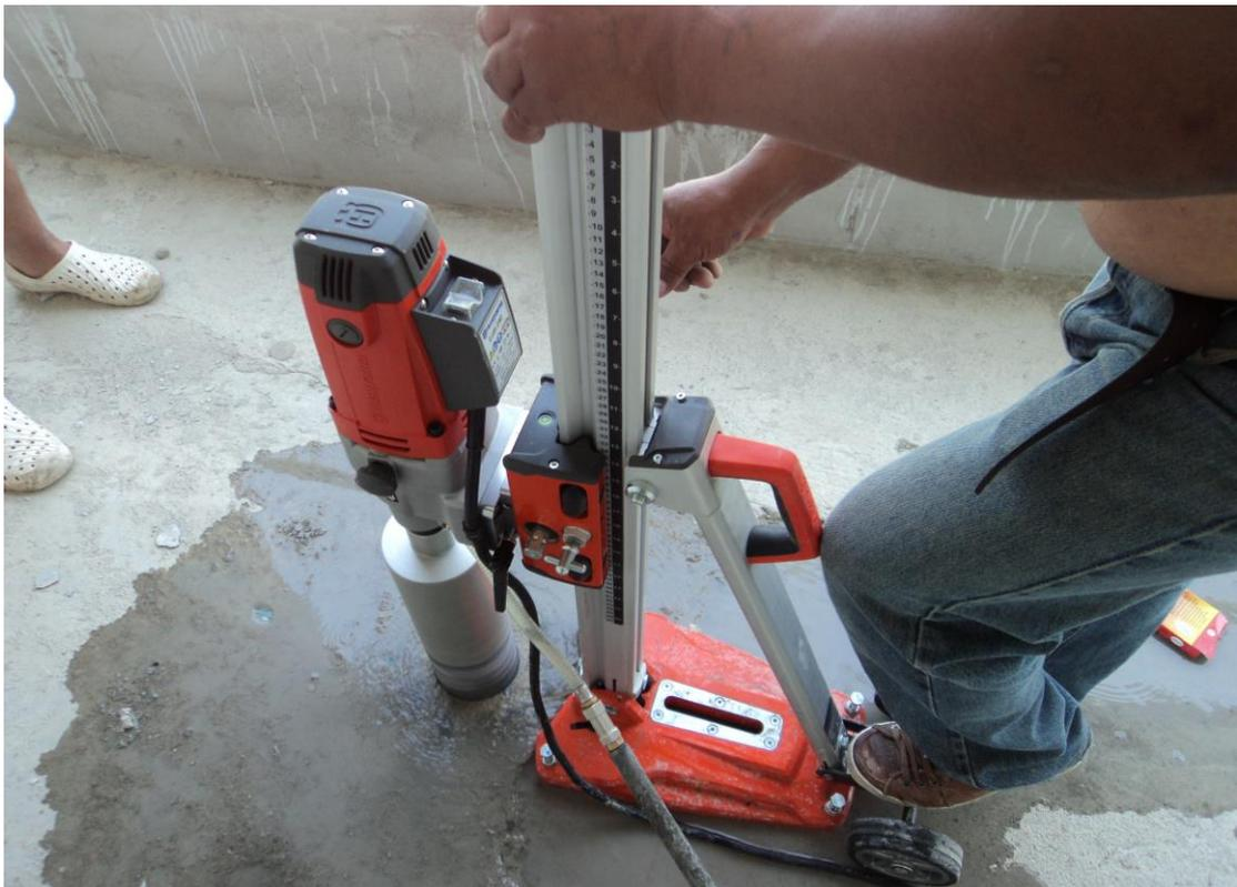
**Ilustración 59.** Perforación de losa para paso de tubería
