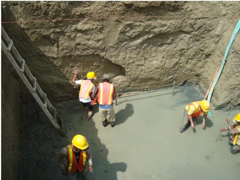
**Ilustración 25. Excavación a mano de Plintos**
