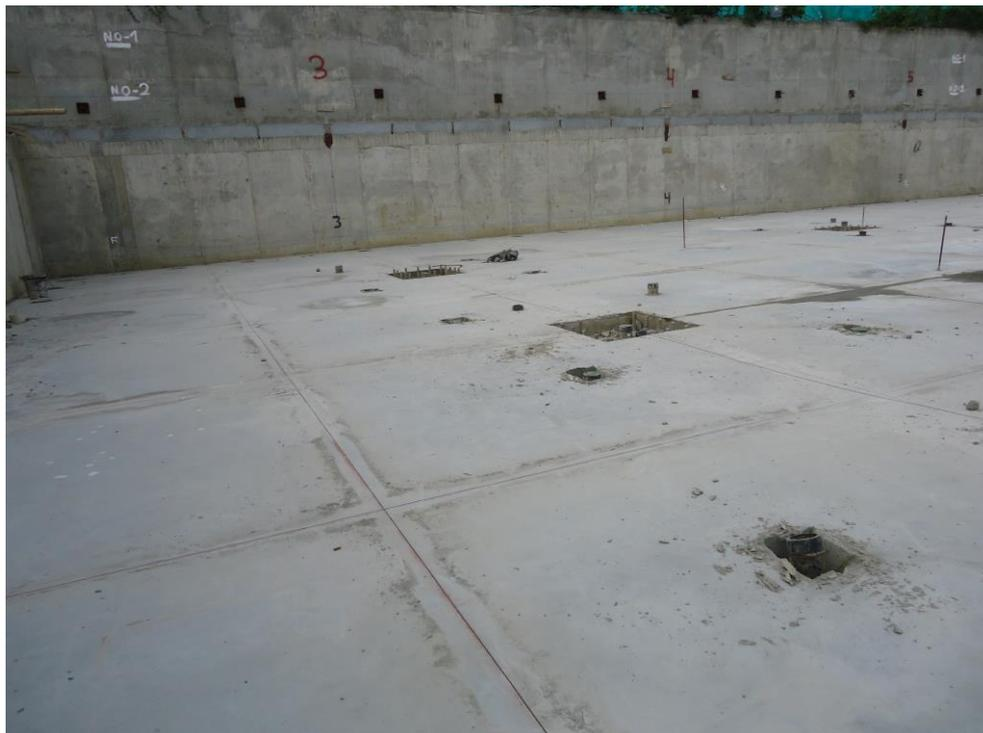
**Ilustración 34. Corte de Juntas Contrapiso**
