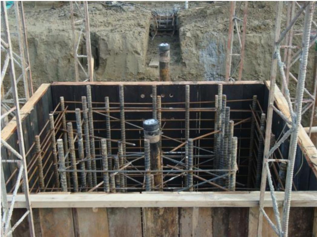
**Ilustración 29. Armado y encofrado de pedestales**
