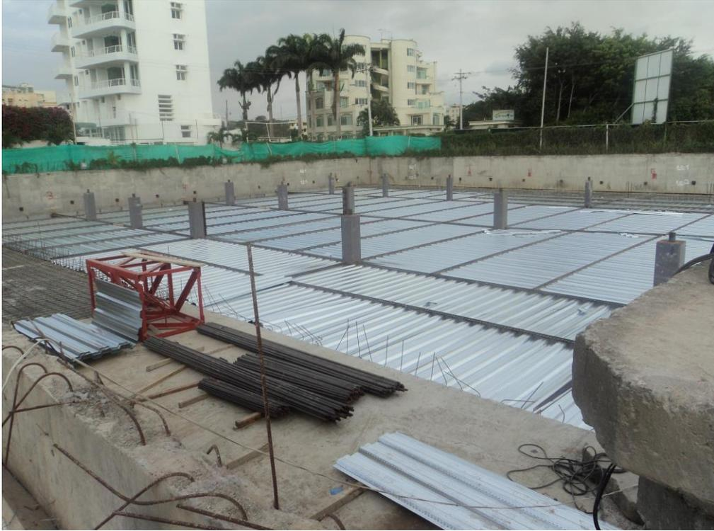
**Ilustración 44. Instalación de deck**
