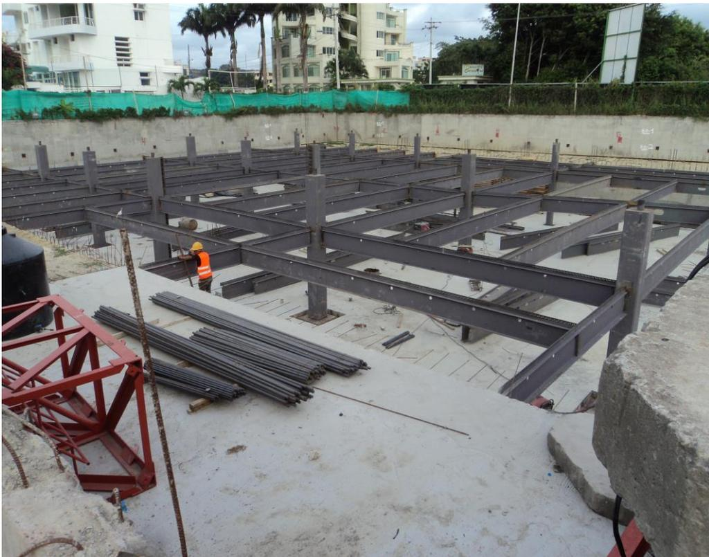
**Ilustración 37. Montaje de Vigas**
