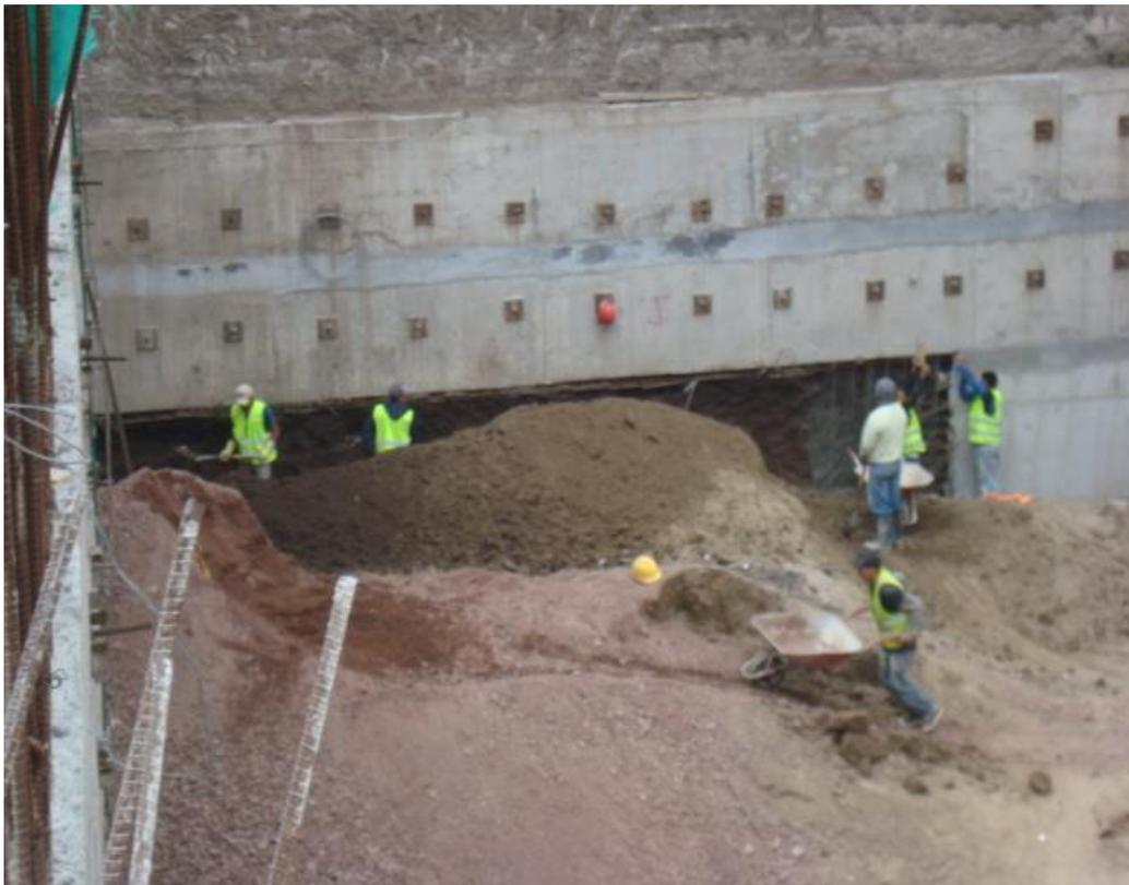
**Ilustración 18. Perfilado y excavación a mano**
