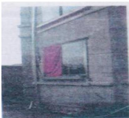
Foto 21 Fisuras en columnas y paredes producidas por asentamiento.
