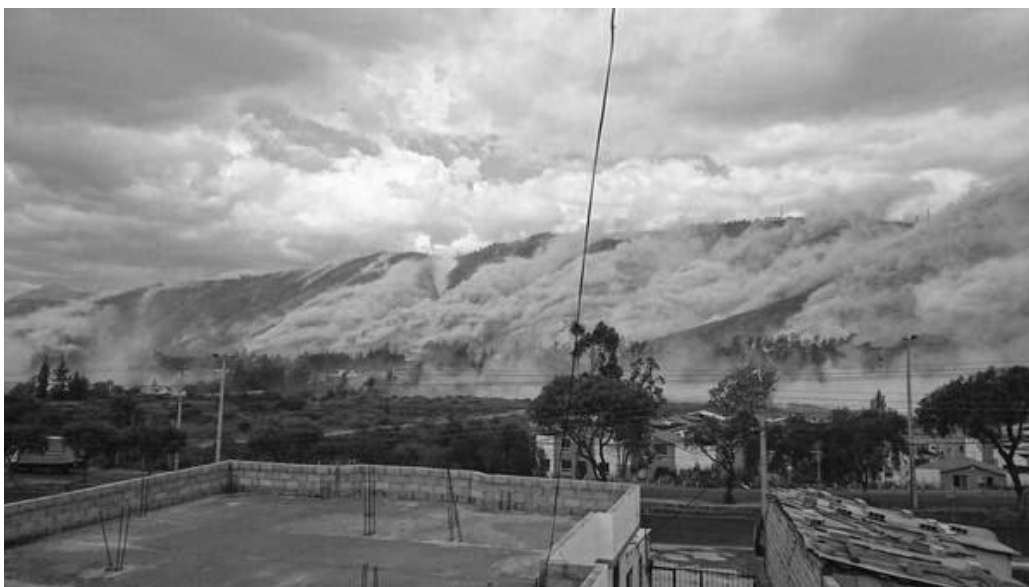
Figura 1: Deslizamientos en las canteras de Pomasqui (tomado de Últimas Noticias)
