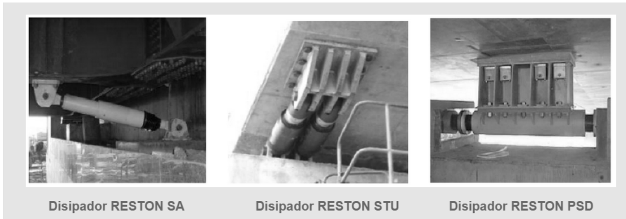
FIGURA 19: TIPOS DE DISIPADORES SÍSMICOS
