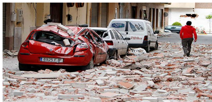
Figura 50- Ejemplo de caída de ladrillos que se desprenden de una pared en un piso superior y causan daños durante el terremoto de Lorca, España. 11 de Mayo de 2011
