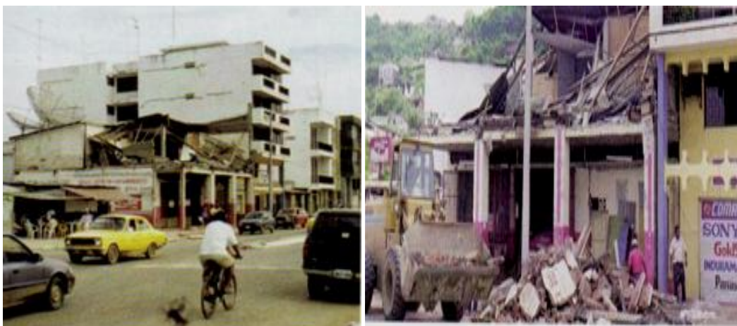
Foto 25- Edificio Cuerpo de Bomberos
