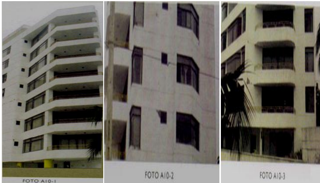
Foto 8- Edificio Torre Mar
