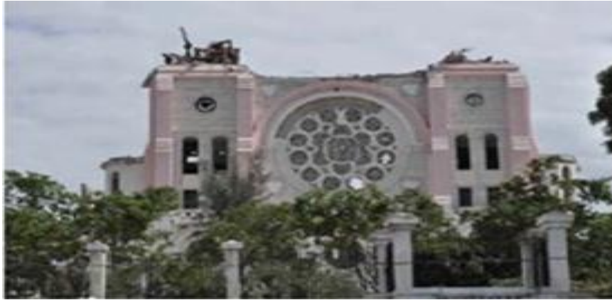
Figura 36- Daños por Torres de Iglesias
