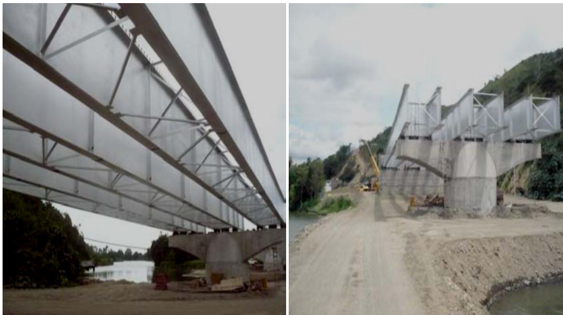
Figura 74- Esmeraldas, Puente Sur
