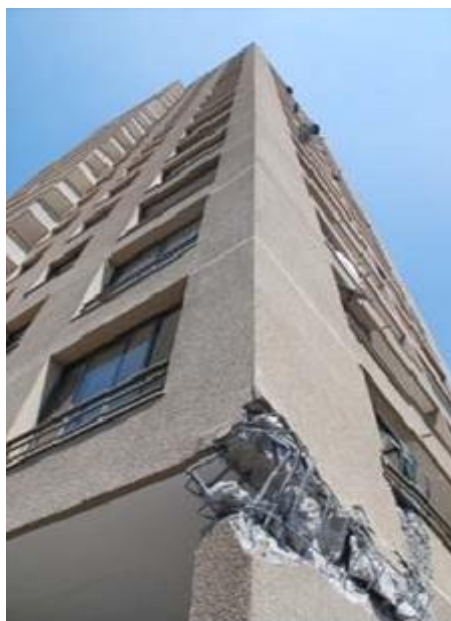
Figura 22- Daños por piso Blando. Sismo de Chile de 2010
