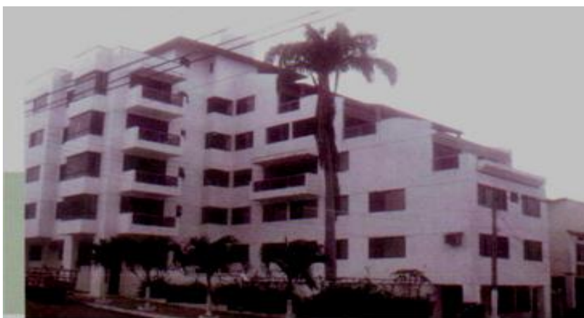
Foto 27- Edificio en Esquina
