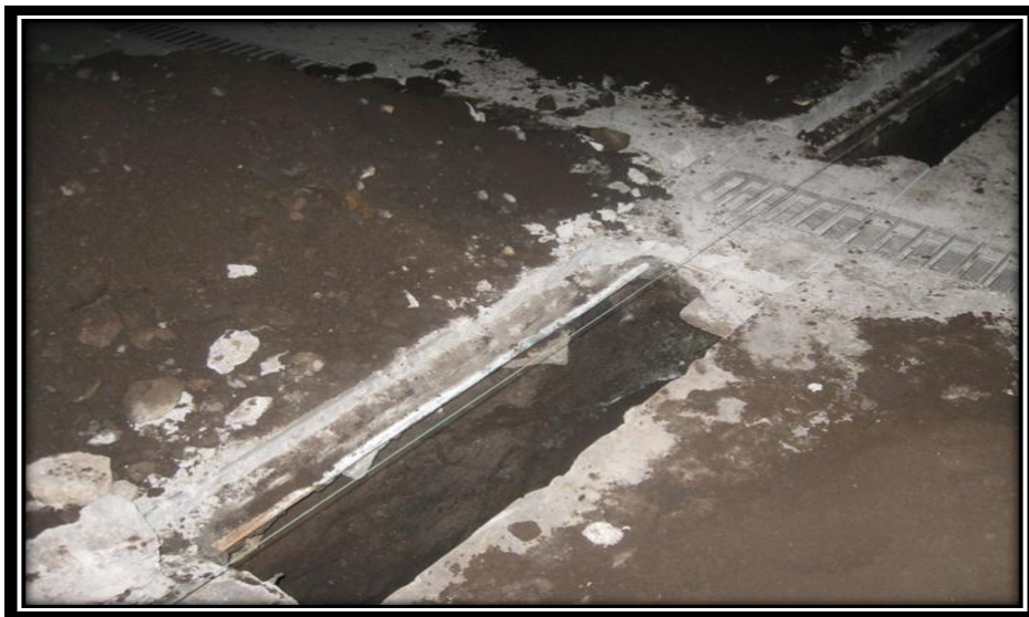
Fotografía 14. Excavación para rejillas
