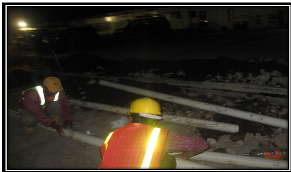
Fotografía 11. Compactación nueva sub-base
