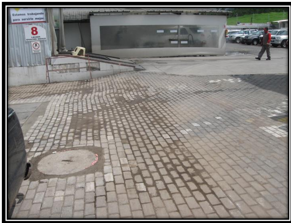
Fotografía 37. Limpieza del terreno para habilitación al siguiente día
