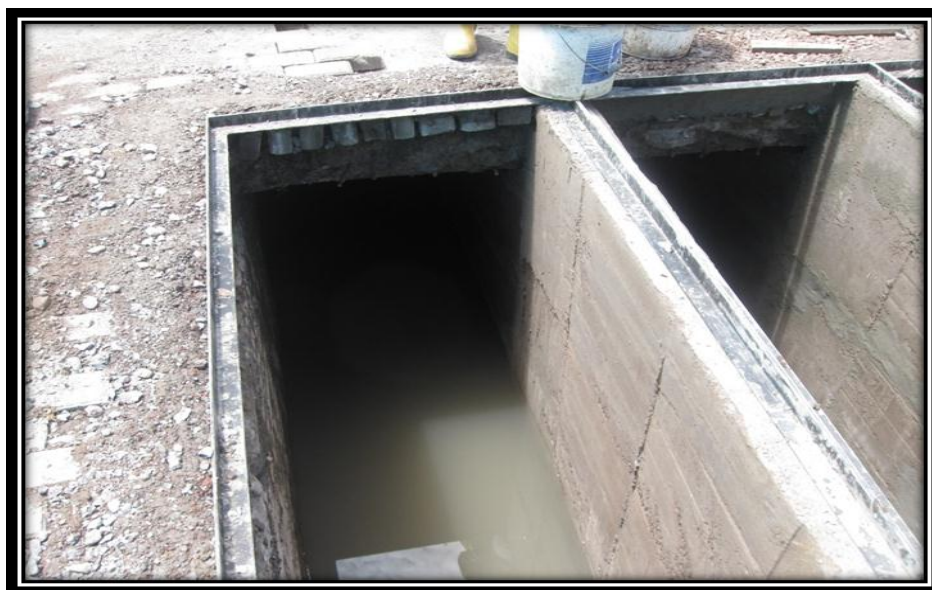
Fotografía 29. Colocación de perfiles de la trampa de grasa
