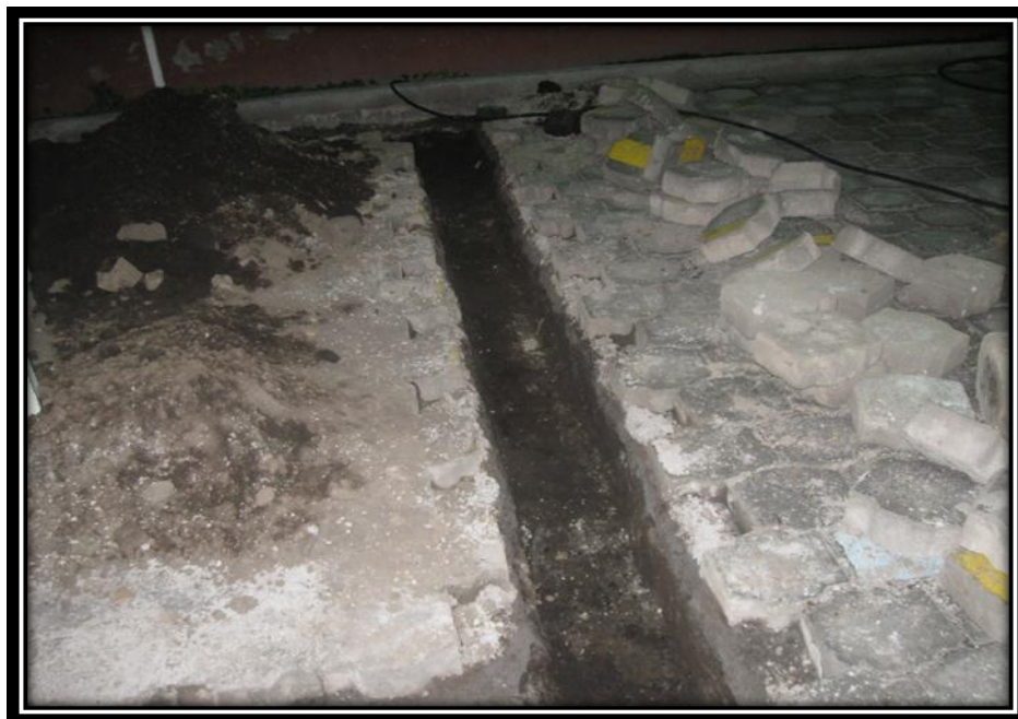
Fotografía 22. Verificación de tubería colocada para sumidero de las rejillas
