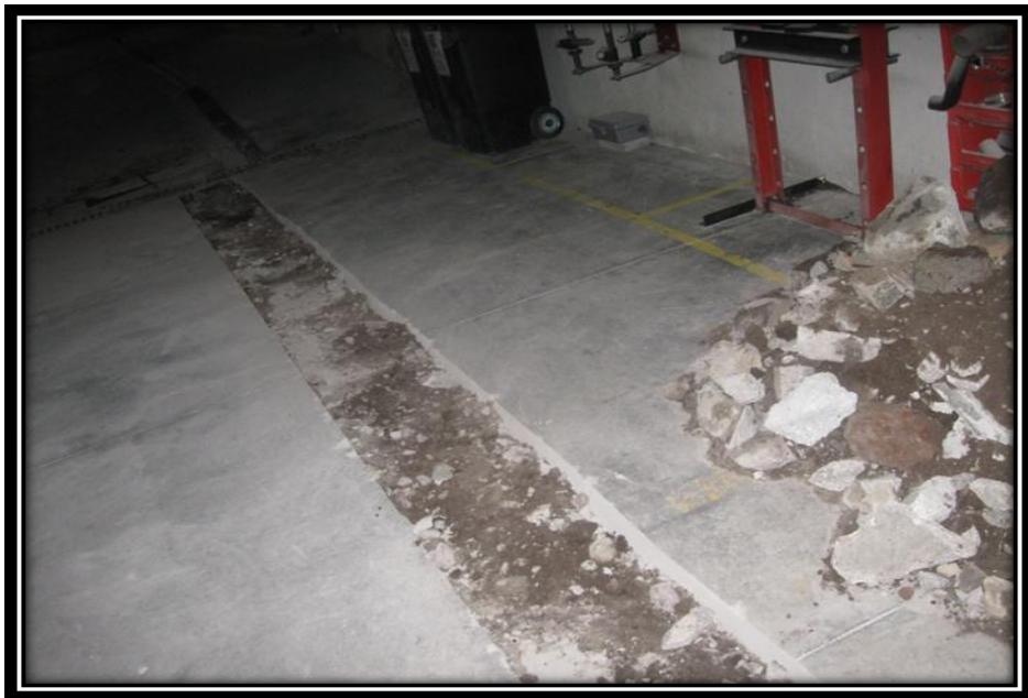
Fotografía 18. Excavación para canales de rejillas
