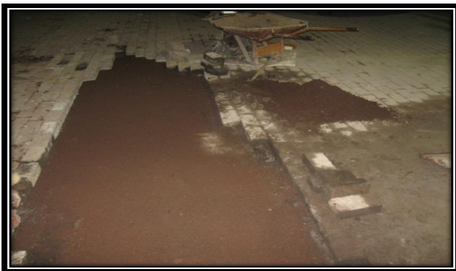
Fotografía 8. Desadoquinado
