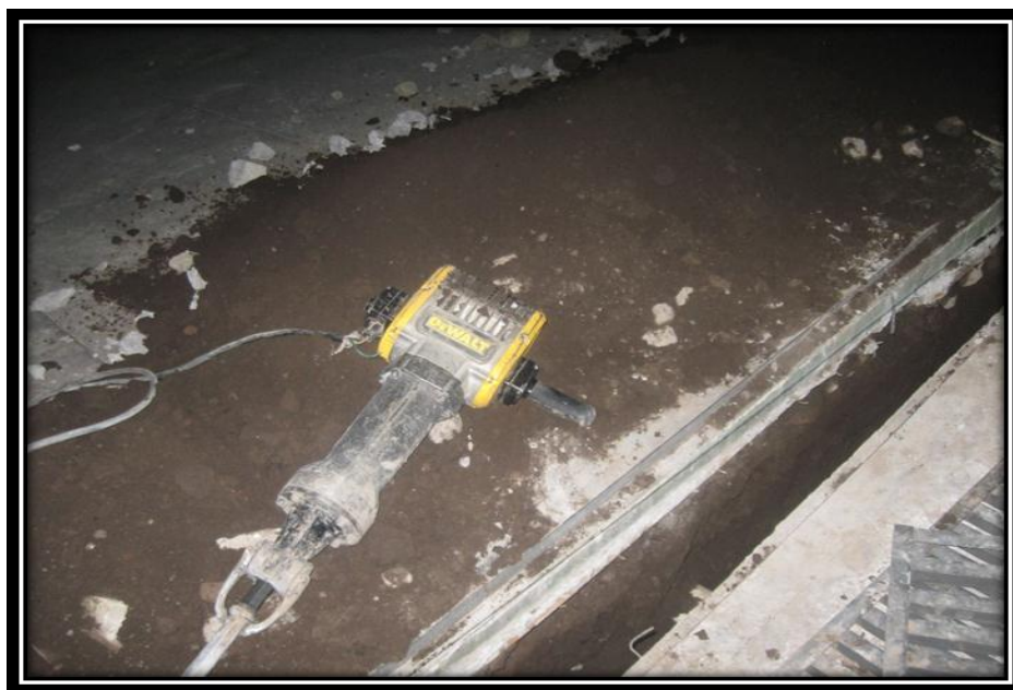
Fotografía 15. .Rotura con equipo mecanico
