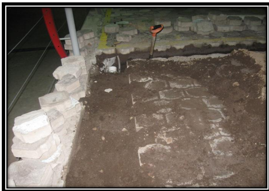
Fotografía 20. Readoquinado
