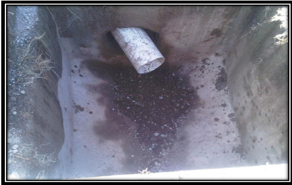
Fotografía 17. Excavación para caja de revisión caja para mantenimiento
