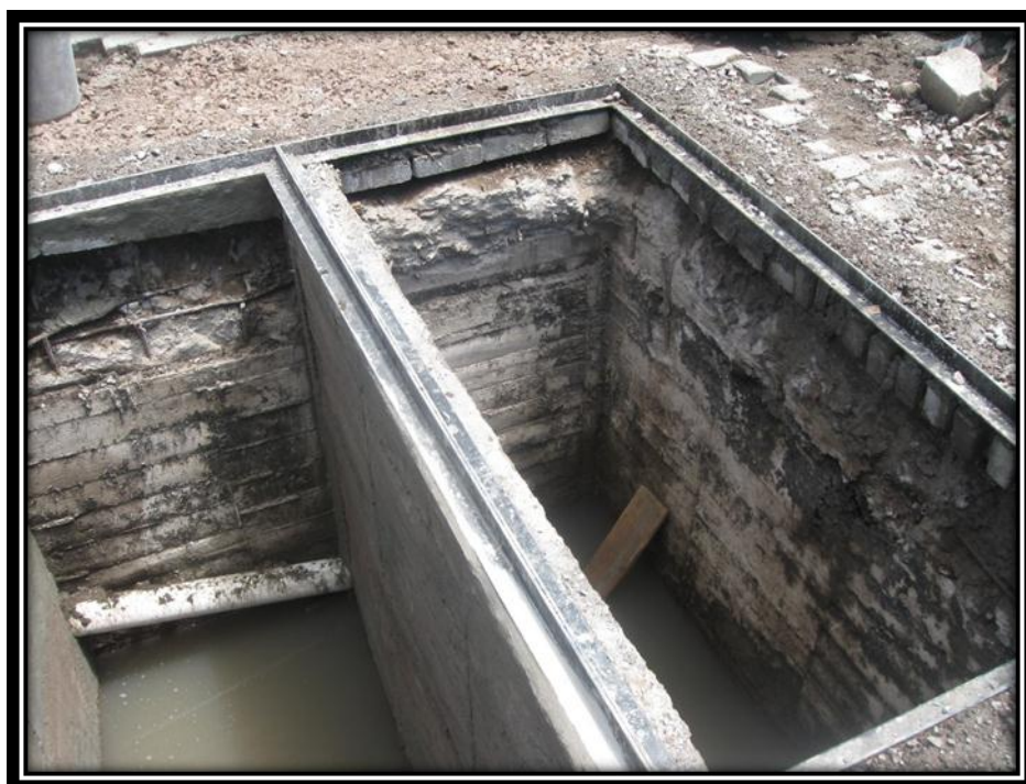
Fotografía 30. Enlucido vertical de paredes de la trampa de grasa
