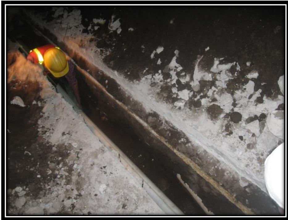
Fotografía 23. Tendido de tubería para rejillas
