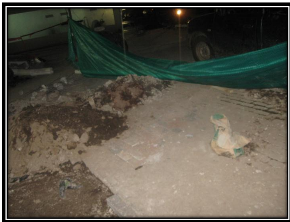
Fotografía 25. Trabajos varios para trampa de grasa
