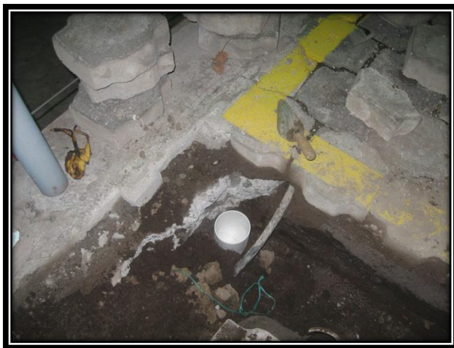
Fotografía 21. Colocación de codo para la rejilla del sumidero
