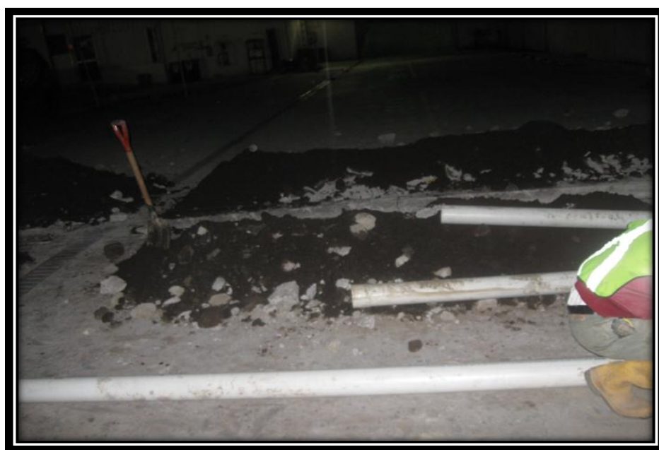
Fotografía 12. Tubería de PVC para división hidrosanitaria
