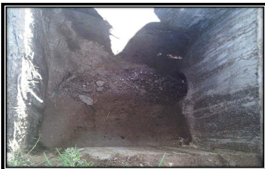
Fotografía 16. Excavación en suelo natural para colocación dela tuberia
