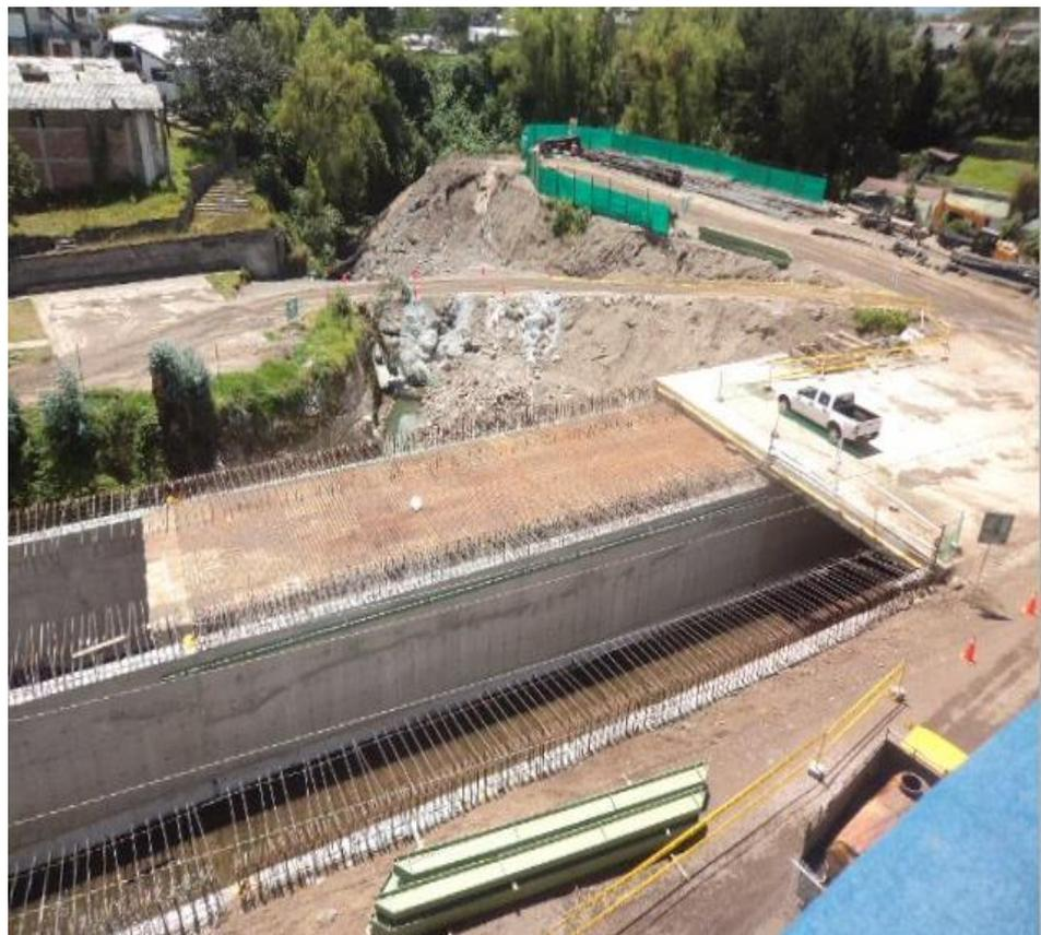
**Figura 44.** Losa superior II
