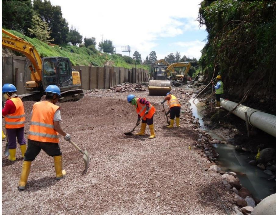
**Figura 35.** Mejoramiento del suelo para fundir losa de cimentación II
