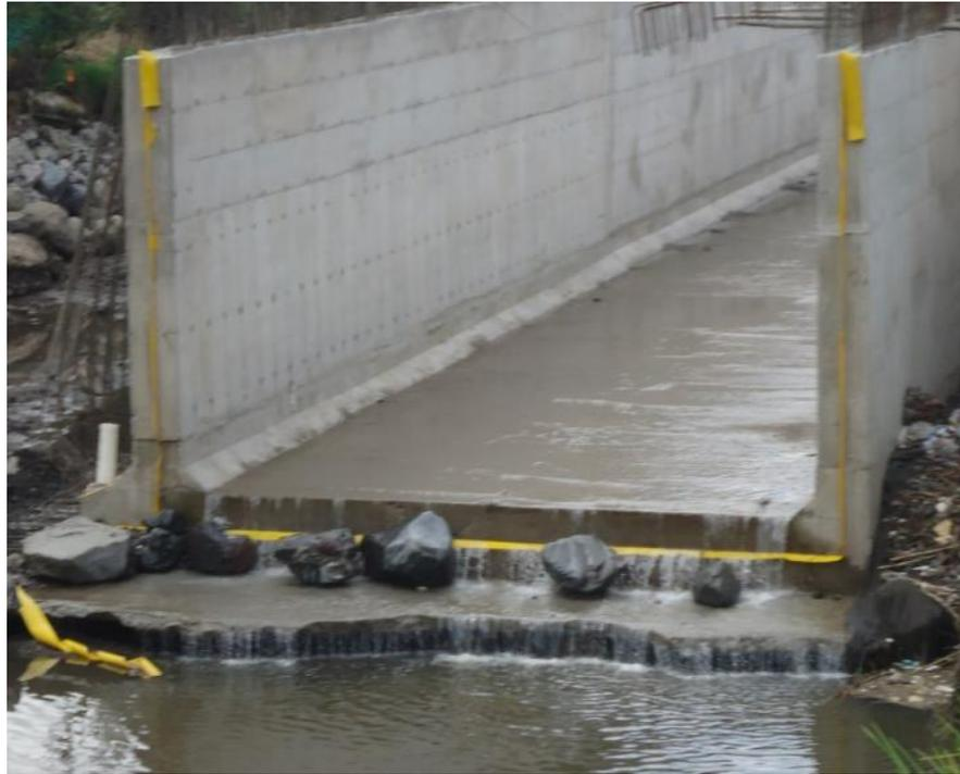
**Figura 41.** Celda 1 terminada, cauce del río desviado I
