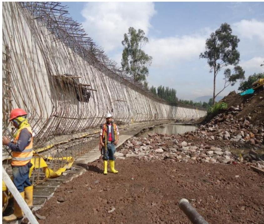
**Figura 36.** Mejoramiento del suelo para fundir losa de cimentación III
