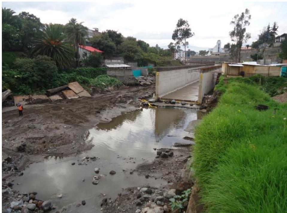
**Figura 42.** Celda 1 terminada, cauce del río desviado II
