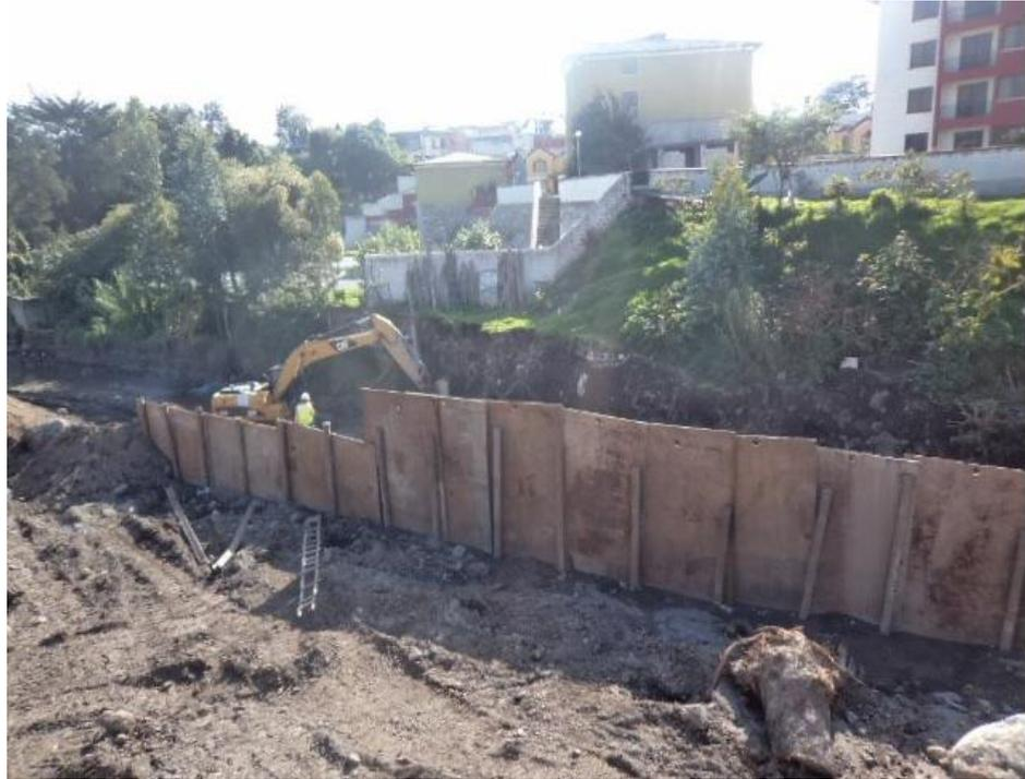
**Figura 24.** Colocación del tablestacado cauce bajo del río I
