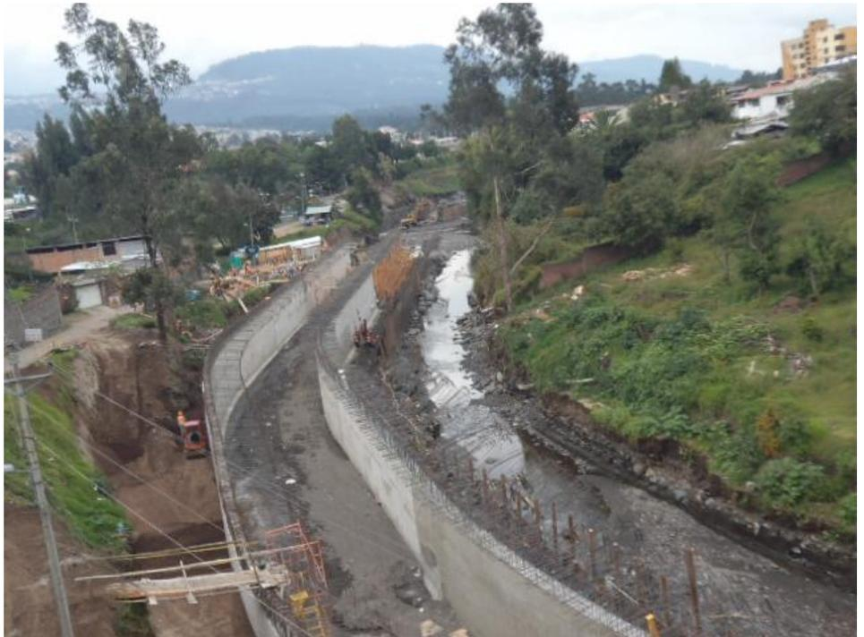
**Figura 40.** Fundición de los muros II
