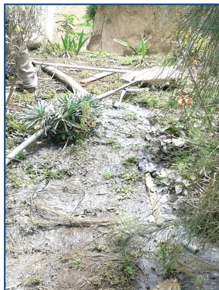
Fotografía 2.5: Problemas de descarga de aguas servidas
