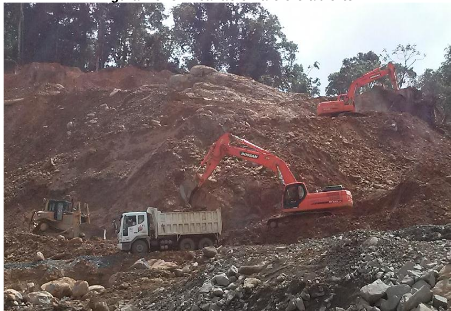
Figura No. 3 Excavación a cielo abierto.
