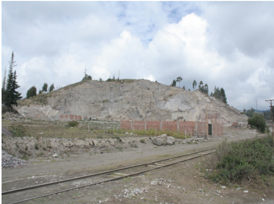
Ilustración 1: Estado actual del área a intervenir.
