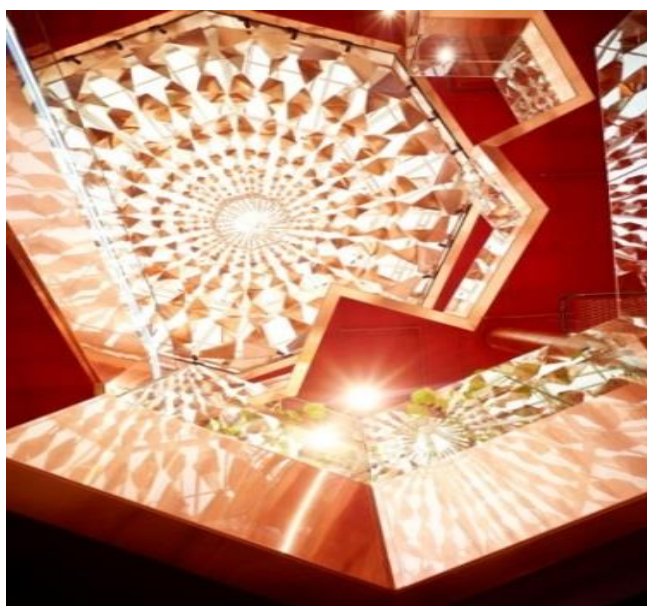
Ilustración 26. Cubierta Centro comercial Paleet
