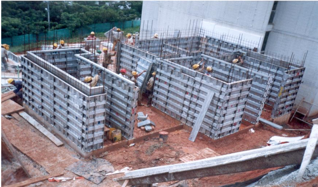
Foto 2.2.1d: Encofrado de paredes en sistema de paredes portantes.
