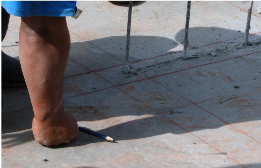
Foto 2.2.1b: Replanteo de paredes en sistema de paredes portantes.
