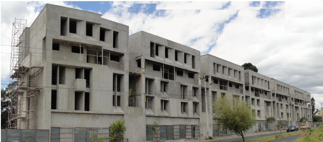
Foto 3.2d: Obra en ejecución con sistema Emmedue calle Rumichaca.
