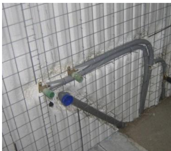
Foto 2.3.1d: Colocación de tuberías hidrosanitarias y eléctricas sistema Emmedue.
