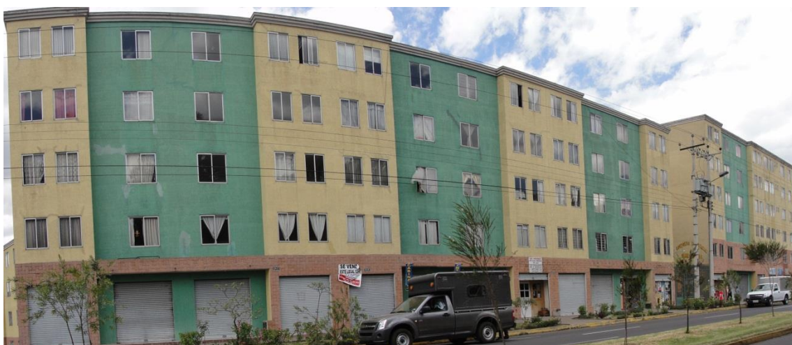
Foto 3.2b: Obra ejecutada con sistema de paredes portantes calle Rumichaca.
