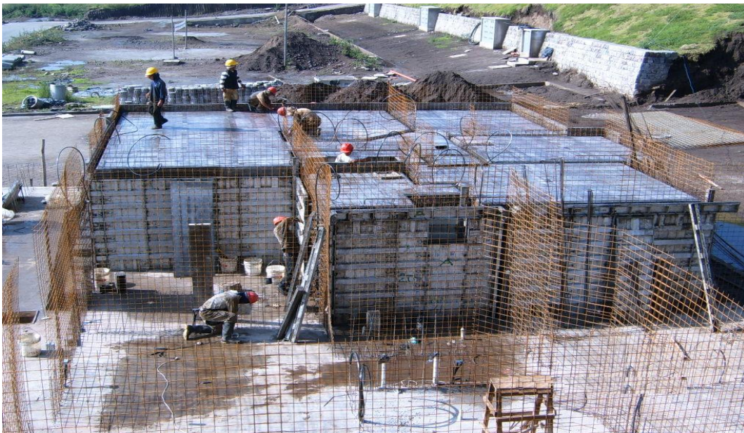
Foto 2.2.1d: Encofrado de paredes y losa en sistema de paredes portantes.
