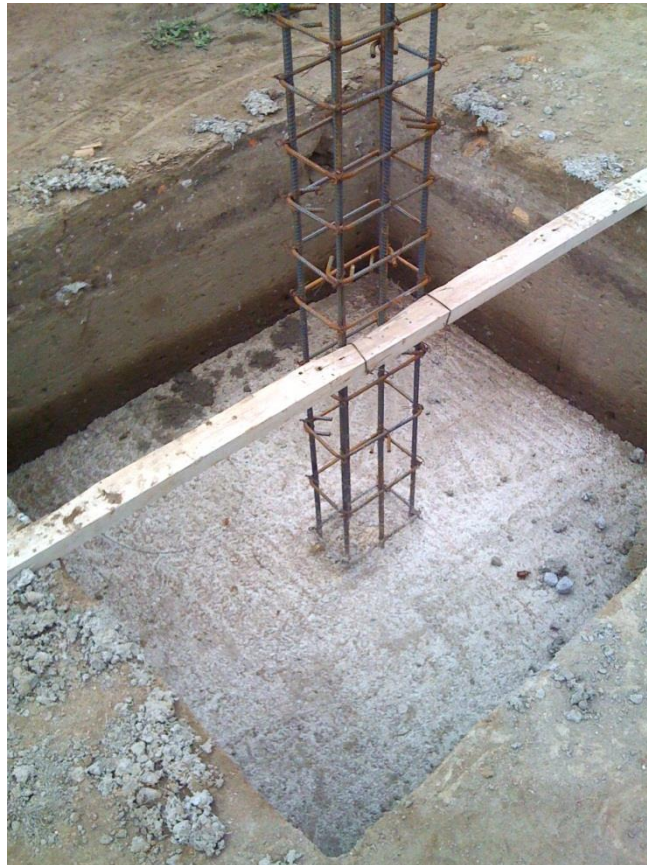
Foto 2.1.1.1: Plinto del sistema aporcado de hormigón armado.
