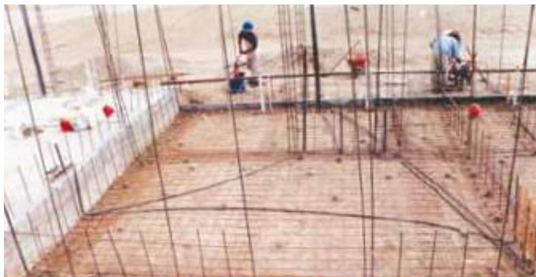
Foto 2.2.1.1: Cimentación superficial sistema de paredes portantes.
