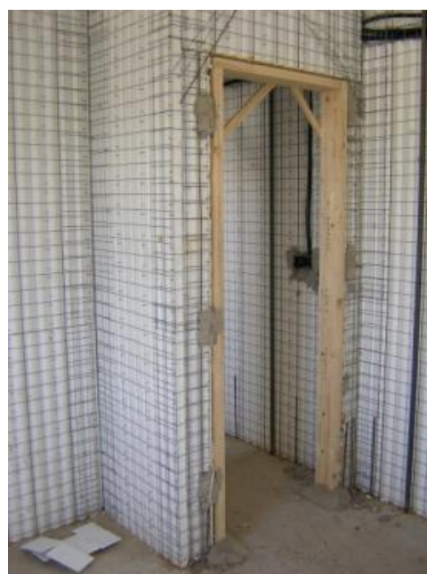
Foto 2.3.1e: Fijación de carpintería sistema Emmedue.
