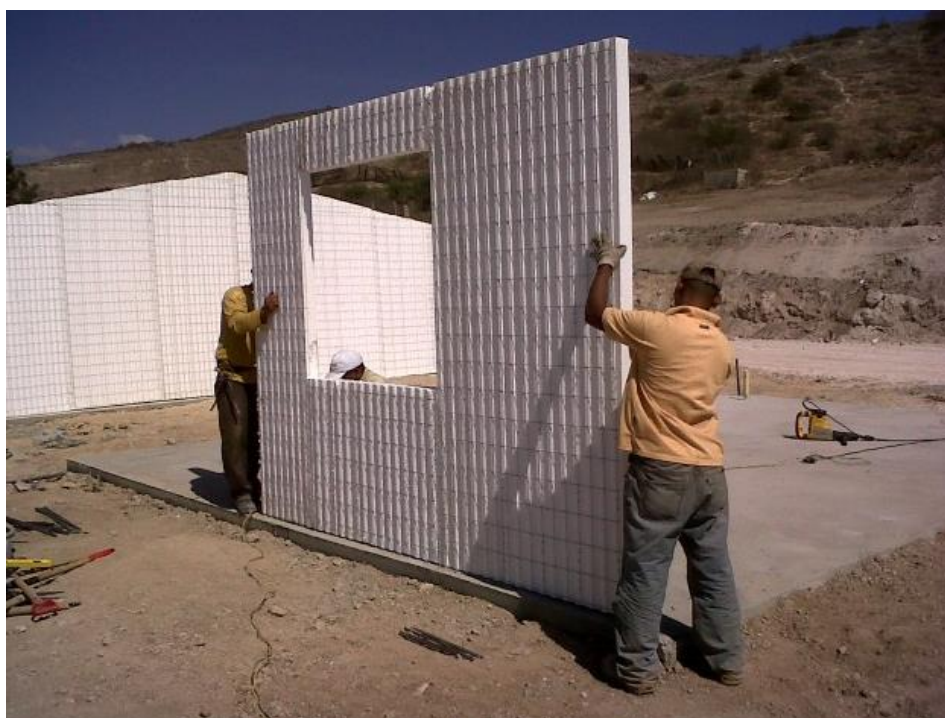
Foto 2.3.1c: Instalación de panel sistema Emmedue.
