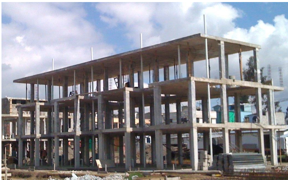
Foto 2.1: Sistema aporticado de hormigón armado.
