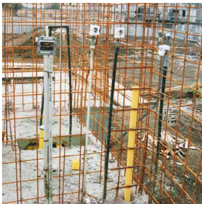
Foto 2.2.1.2: Instalaciones eléctricas y sanitarias embebidas.
