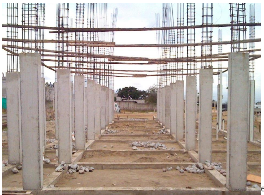
Foto 2.1.1.2: Columnas del sistema aporticado de hormigón armado.
