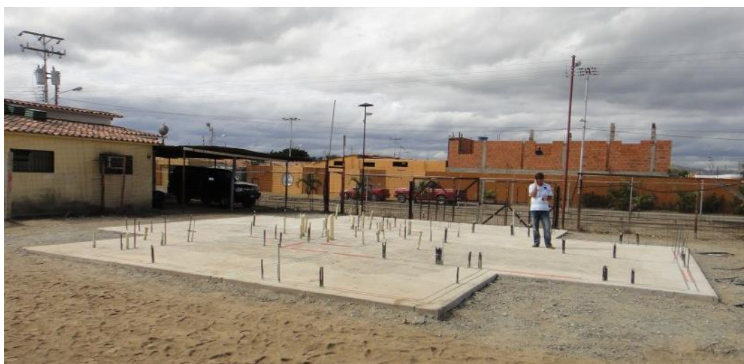
Foto 2.3.1: Losa de cimentación sistema Emmedue.
