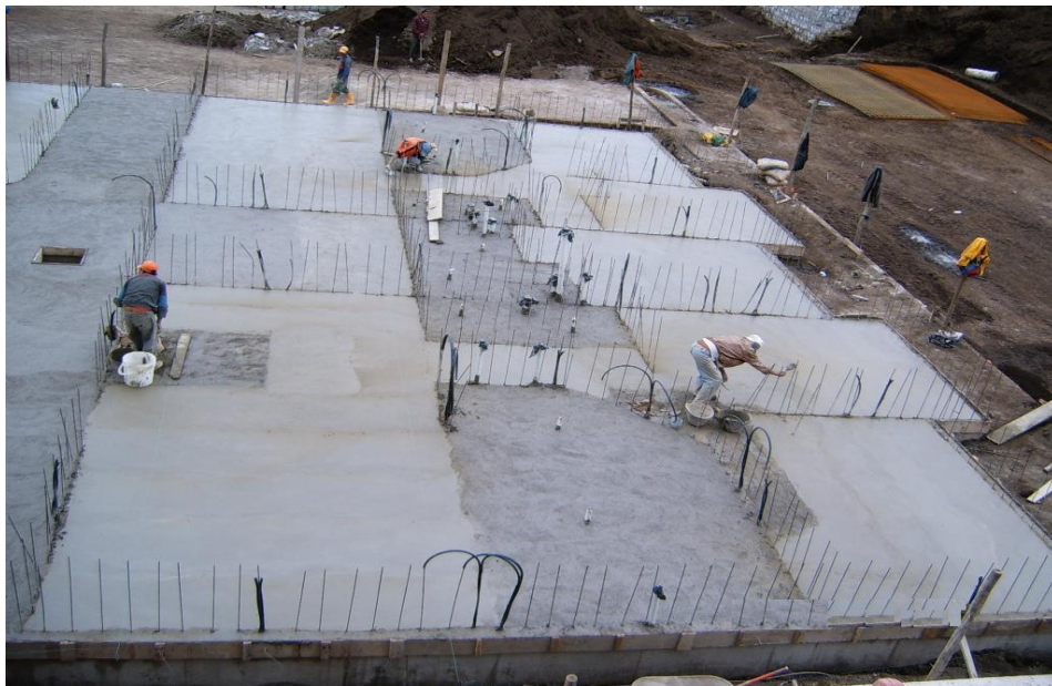
Foto 2.2.1a: Chicotes de varilla como anclajes en losa de cimentación sistema de paredes portantes.
