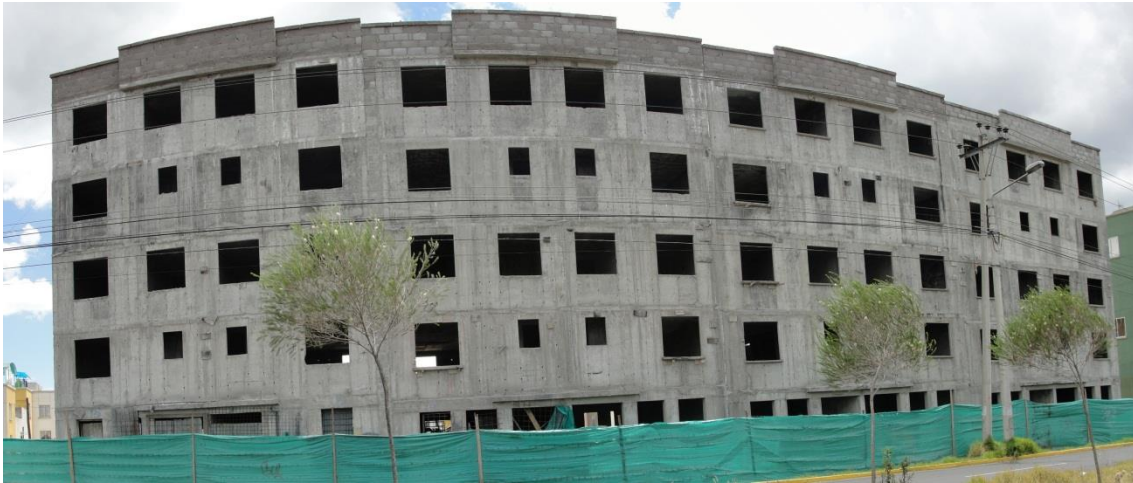
Foto 3.2c: Obra en ejecución con sistema de paredes portantes calle Rumichaca.
