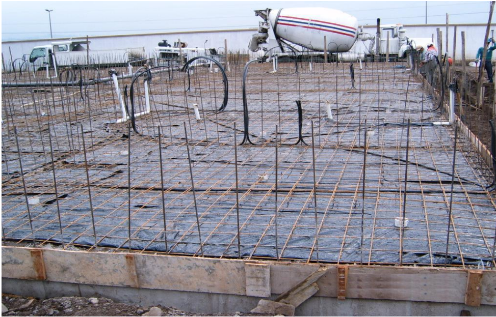
Foto 2.2.1: Losa de cimentación sistema de paredes portantes.
