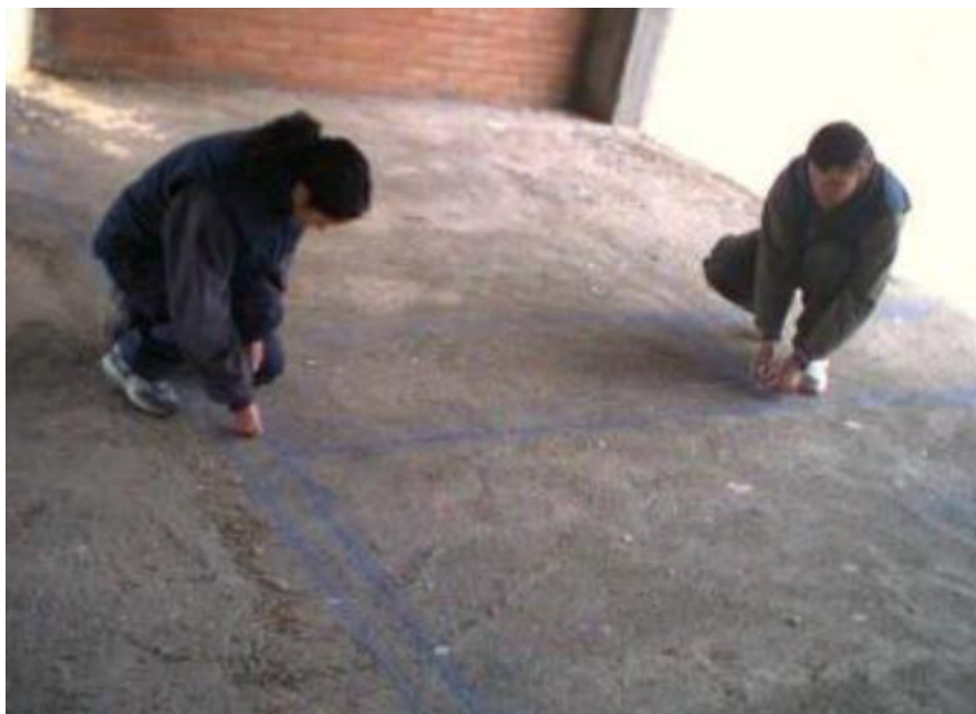
Foto 2.3.1a: Trazado y timbrado para paredes sistema Emmedue.
