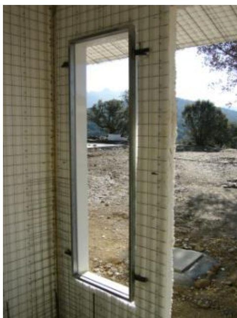
Foto 2.3.1e: Fijación de carpintería sistema Emmedue.
