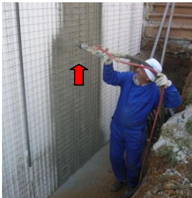
Foto 2.3.1c: Proyección micro hormigón sobre panel sistema Emmedue.
