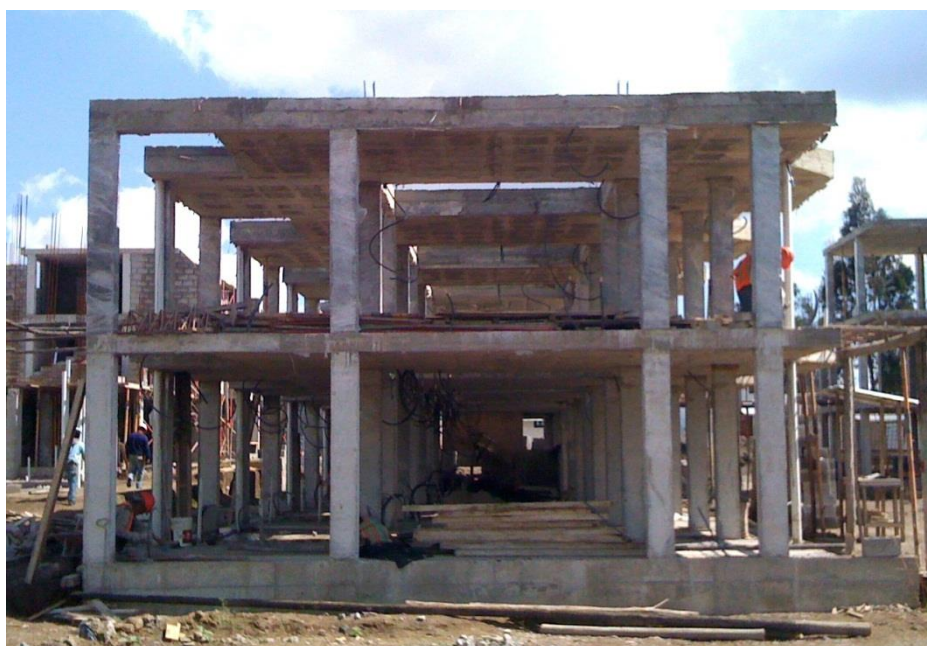
Foto 2.1.1.3: Vigas y losa del sistema aporticado de hormigón armado.
