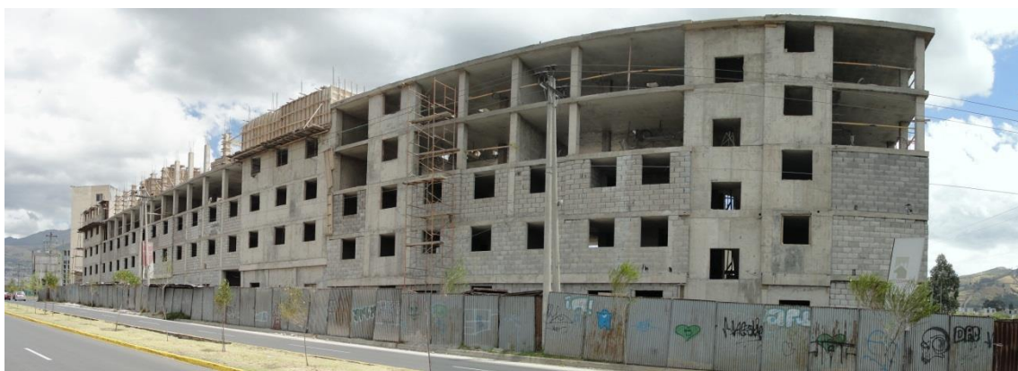
Foto 3.2a: Obra en ejecución con sistema tradicional aporticado calle Rumichaca.
