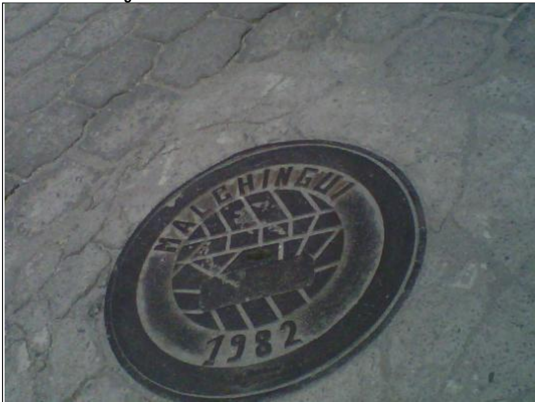
Fotografía 2.3: Alcantarillado Combinado existente
