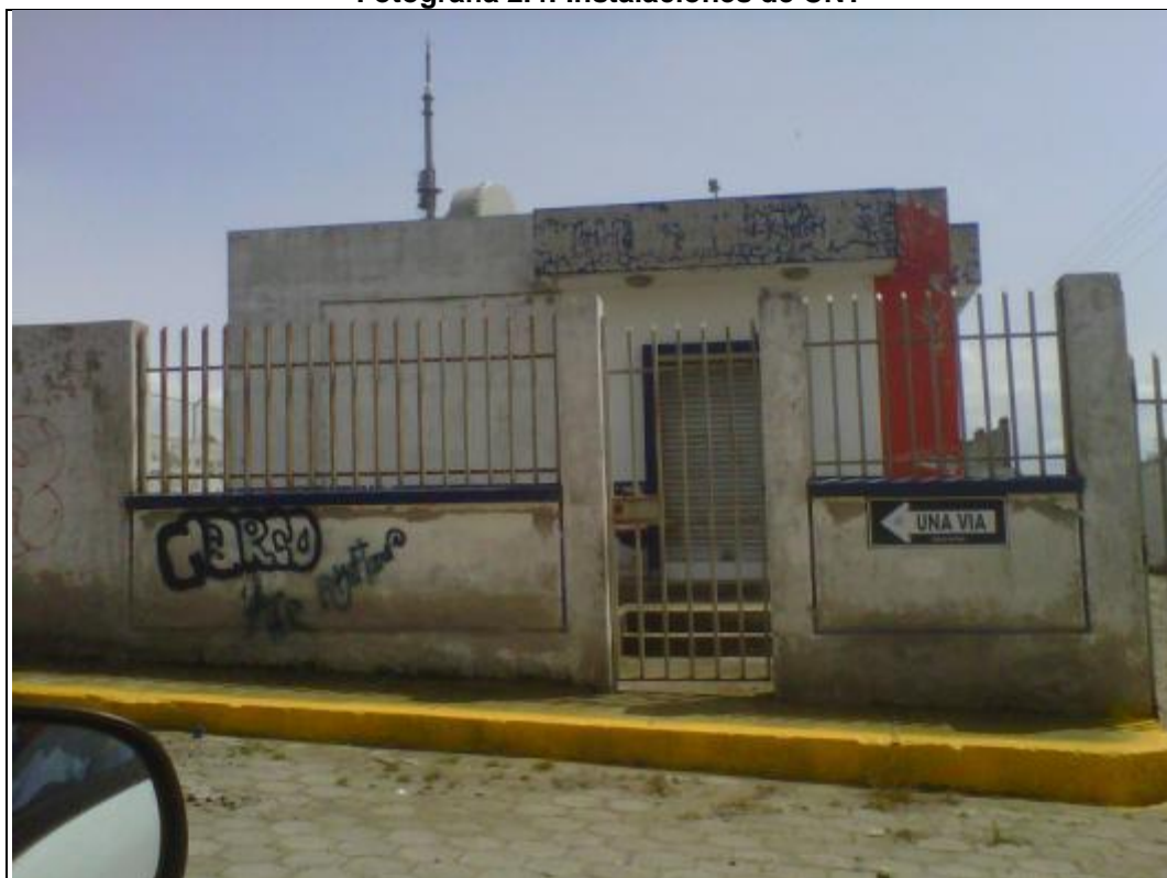
Fotografía 2.4: Instalaciones de CNT
