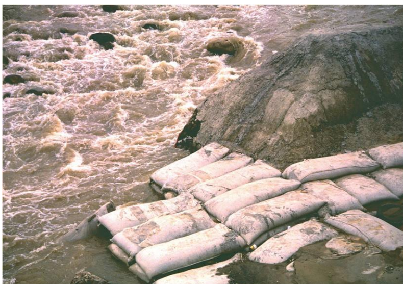
Foto 5. Colchonetas de gaviones para aguantar la fuerza de la corriente
