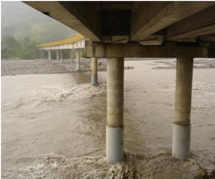
Foto 3 . Colocación de pilas al paso de la corriente
