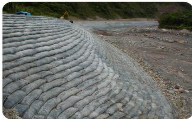
Foto. 7 Colocación de bolsacretos
