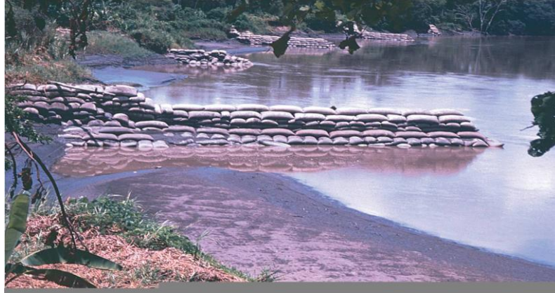
Foto 6. Colocación de espigones aguas arriba del puente
