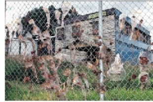
En la av. Maldonado y Pujilí, en el sur. En los exteriores del inmueble hay flores secas y una carta para el grupo Zerstört.
