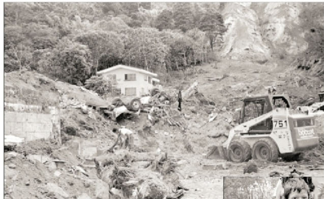
EL RESCATE SIGUE • El alud que cubrió las casas de Las Colinas tiene una dimensión de 150 metros cubicos. 33 camionetas, 4 tractores, una motoniveladora y centenares de socorristas trabajan en la zona.
