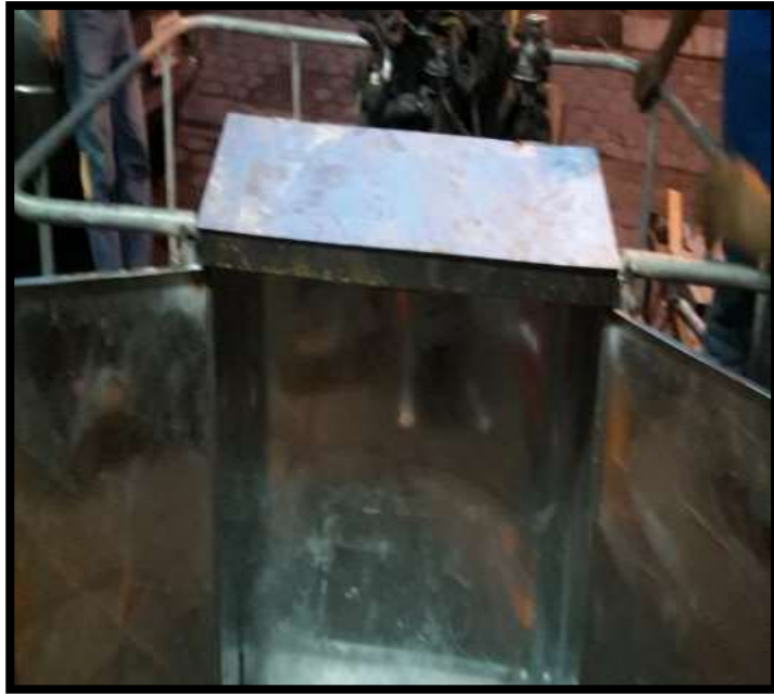
Figura 30: Puertas de panel de control
