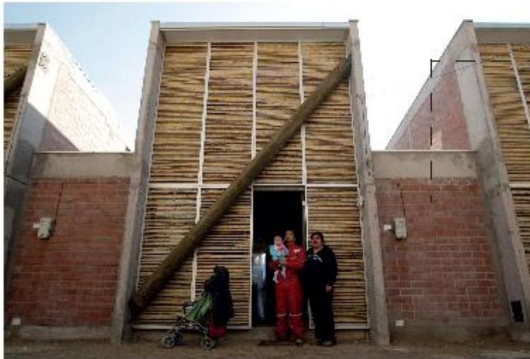
Como técnica constructiva se usó la tradición artesanal de ladrillo y marco de hormigón armado, expresando la correspondencia entre apariencia y naturaleza estructural del proyecto.
