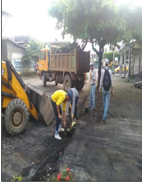
Fotografía 9 Limpieza de canaletas
