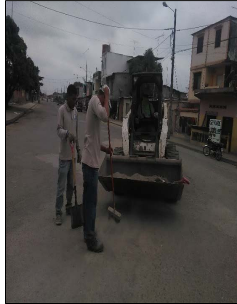
Fotografía 10 Recolección de exceso de concreto
