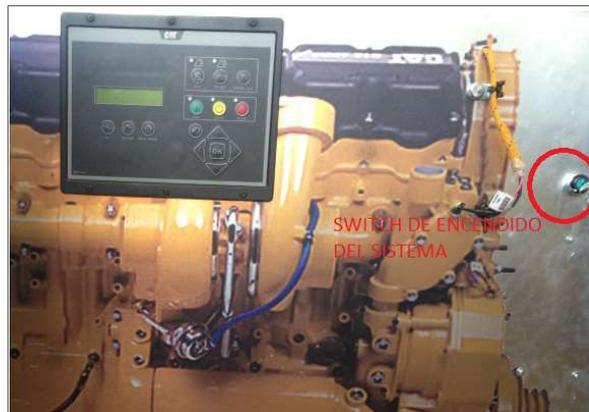
**Figura 164:** Ubicación de switch de encendido
