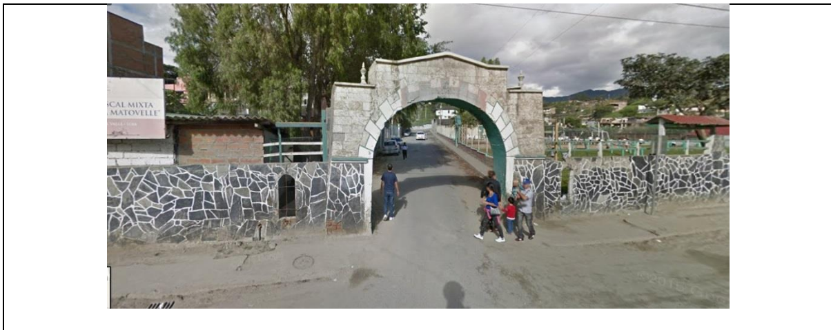
Figura 52. Entrada a la estación Municipal de auxilio terapéutico N-1
