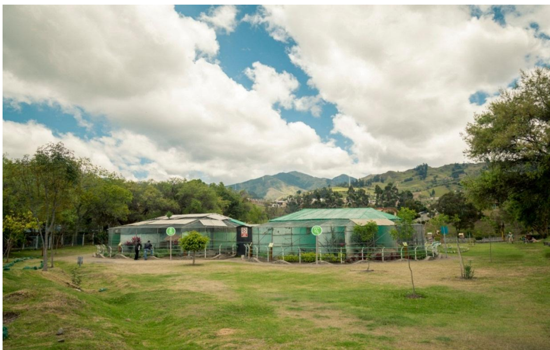
Foto 30. Foto con montaje de las señales de ubicación aplicando el nuevo diseño
