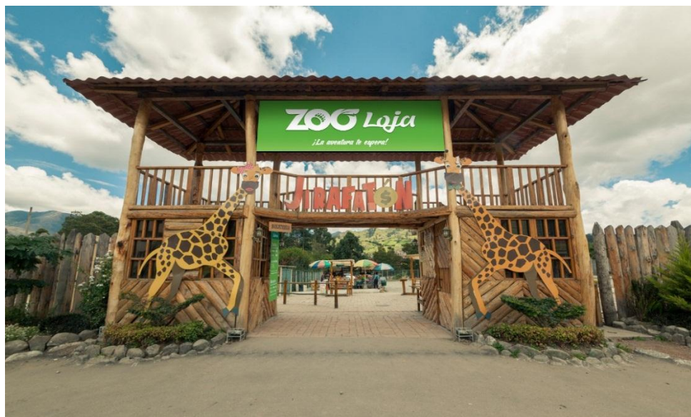
Foto 2. Foto con montaje de la valla principal
