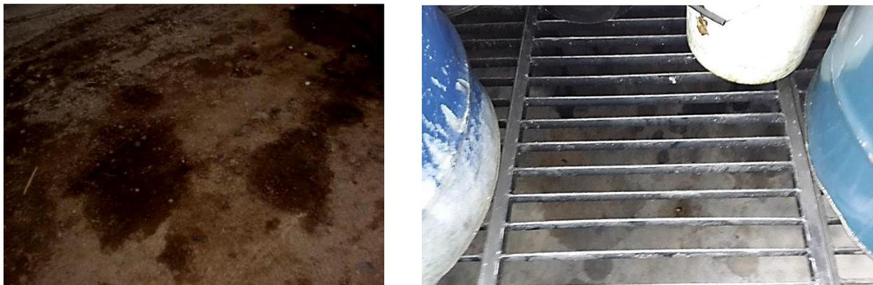
Figura 3.4 Suelos contaminados a causa de aceites lubricantes usados vs pisos impermeables
