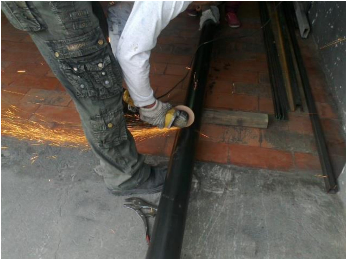
Figura 4.18 Corte de la tubería
