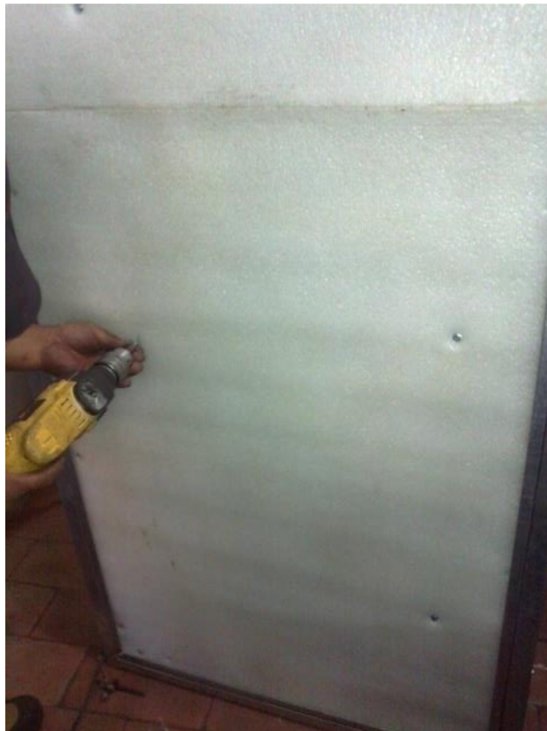
Figura 4.23 Aseguramiento de la poly espuma a la placa de tol Fuente: Guaña, Altamirano, fotografía tomada mayo 2015
