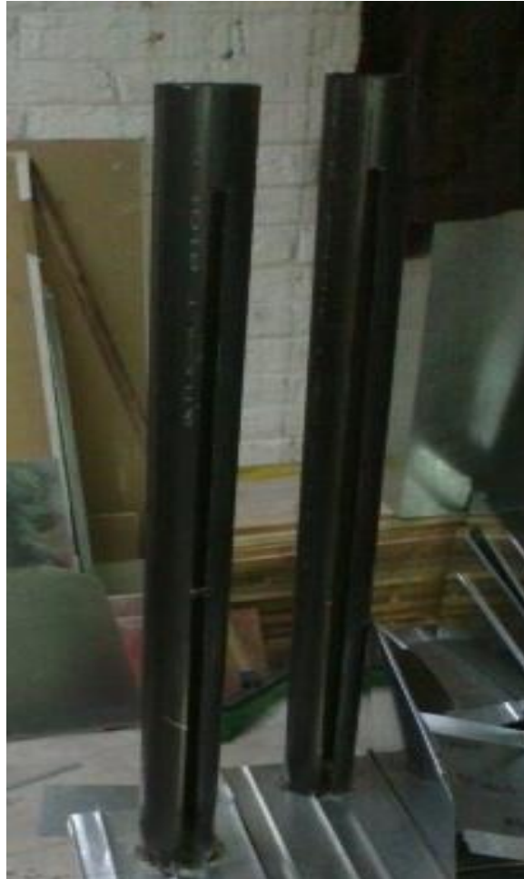
Figura 4.19 Corte en la tubería para acoplamiento con las placas corrugadas Fuente: Guaña, Altamirano, fotografía tomada mayo 2015.
