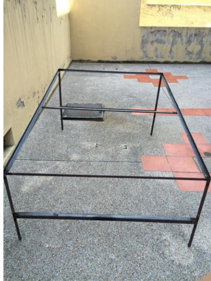
Figura 4.25 Estructura de soporte del colector solar plano Fuente: Guaña, Altamirano, fotografía tomada mayo 2015
