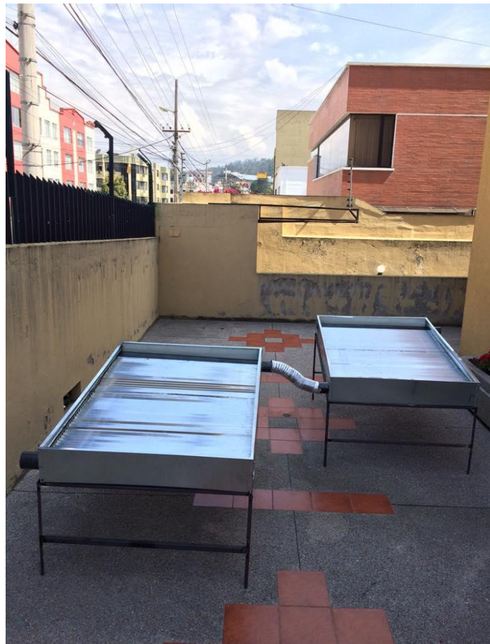
Figura 4.13 Colectores solares planos conectados en serie Fuente: Guaña, Altamirano, fotografía tomada mayo 2015.
