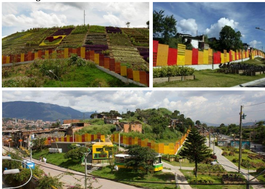
Imagen 047. Estado actual de intervención en barrio Moravia.
