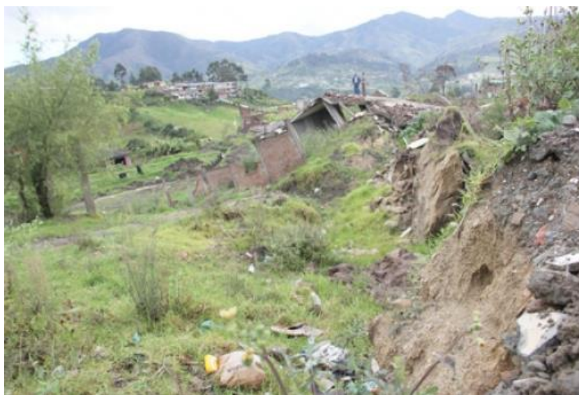
Imagen 061. Deslizamientos de tierras en el barrio la florida.
