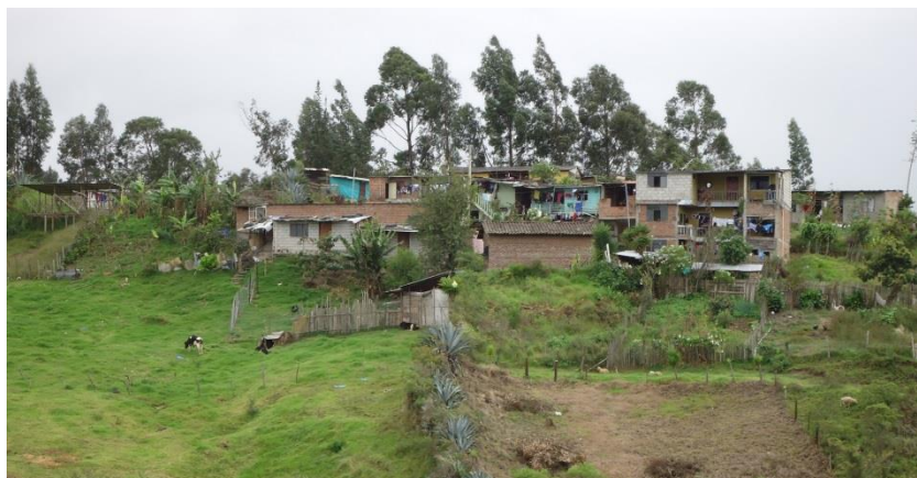
Imagen 026. Estructuras de vivienda en el barrio La Florida.
