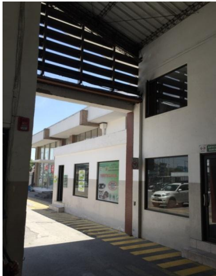
Figura 4.17 Ventilación Entrada Principal Taller
