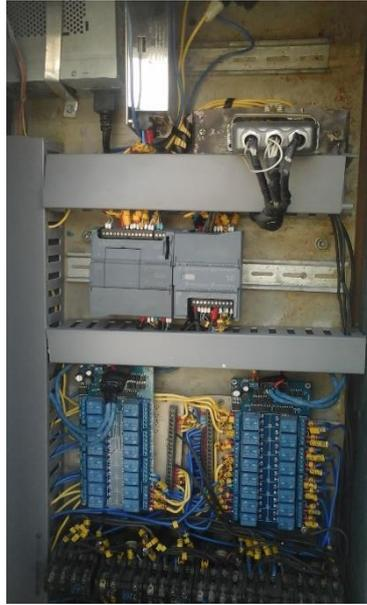
Figura 3.14 Cableado eléctrico hacia el PLC
