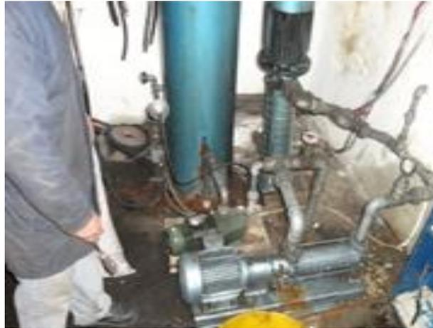
Figura 1.11 Bomba de agua para lavado de carrocería
