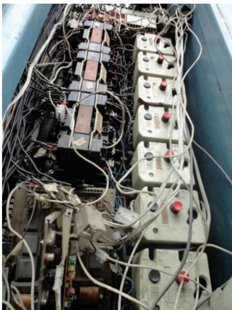
Figura 1.14 Contactores de potencia y guarda motores
