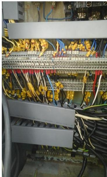
Figura 3.15 Cableado eléctrico de sensores hasta las regletas
