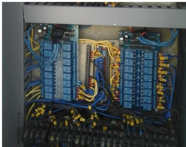
Figura 3.12 Placas de relés ya conectadas a todos los actuadores, en la parte inferior se observan los relés de activación para C1, C2 y C4.
