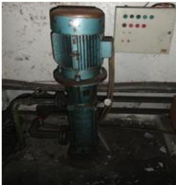
Figura 1.10 Bomba de 15 kW, para lavado de llantas y chasis
