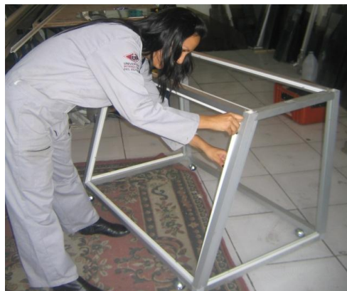
Figura 6. 4: Instalación de la Estructura de Aluminio
