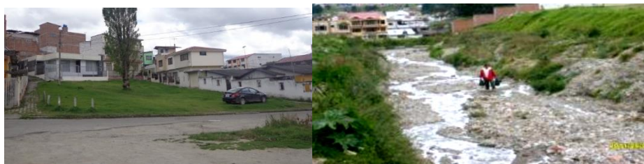
Ilustración 25: Estado actual de aceras del área de estudio
