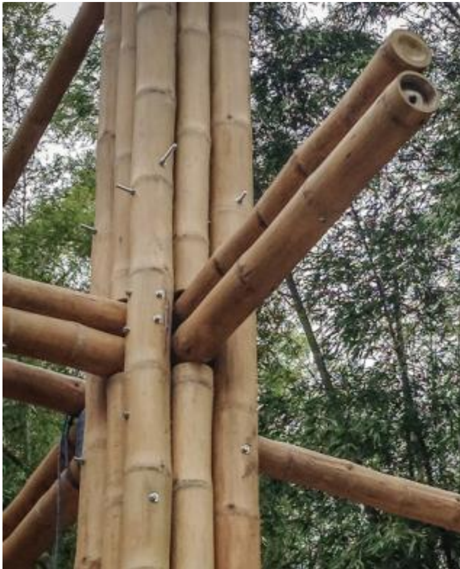
Gráfico 60 Detalle de unión con pernos
