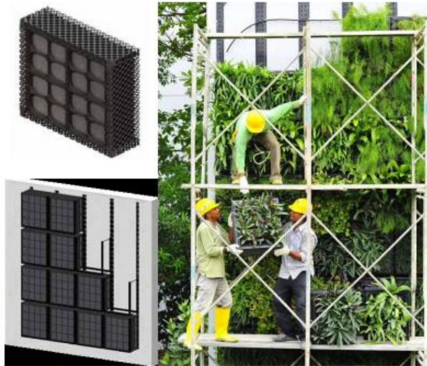
Imagen 17. Sistema modular de paneles vegetados en celdas plásticas
