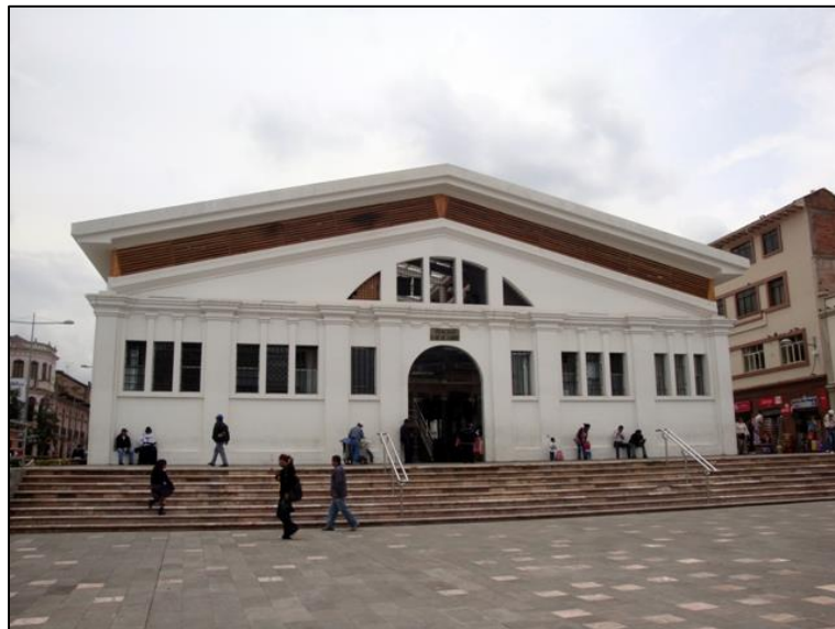
Imagen 20: Vista externa del Mercado 9 de Octubre
