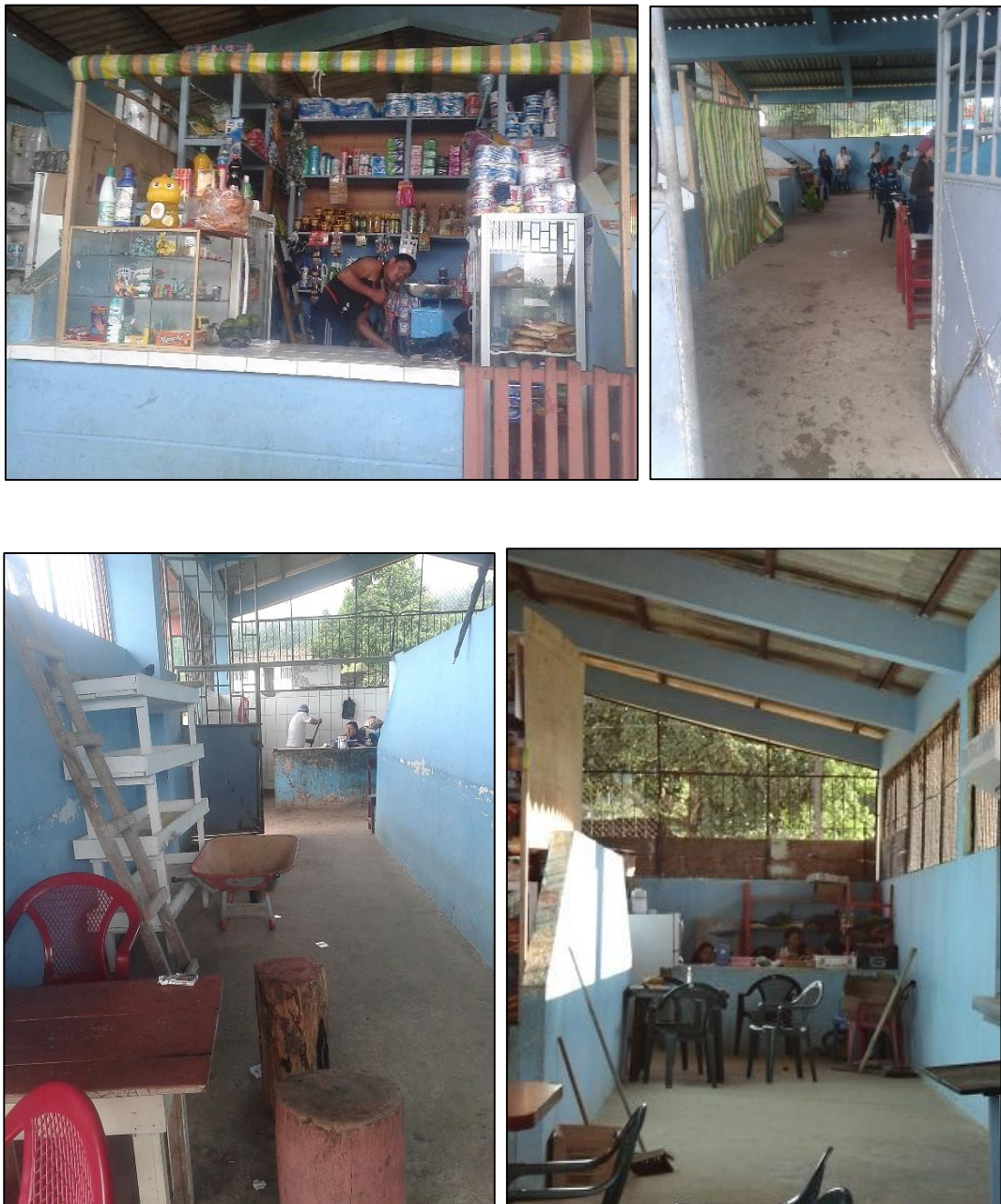
Imagen 33. Estado interno del Mercado
