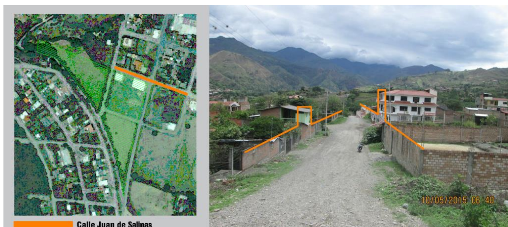
Imagen 47. Perfil urbano de las edificaciones ubicadas en la calle Juan de Salinas
