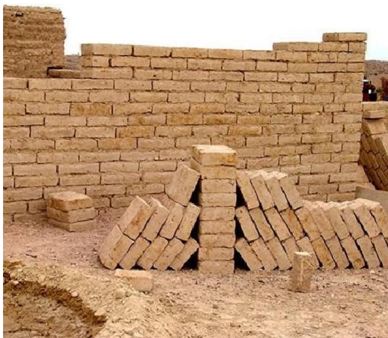
Imagen 18. Pared de adobe fabricada in situ
