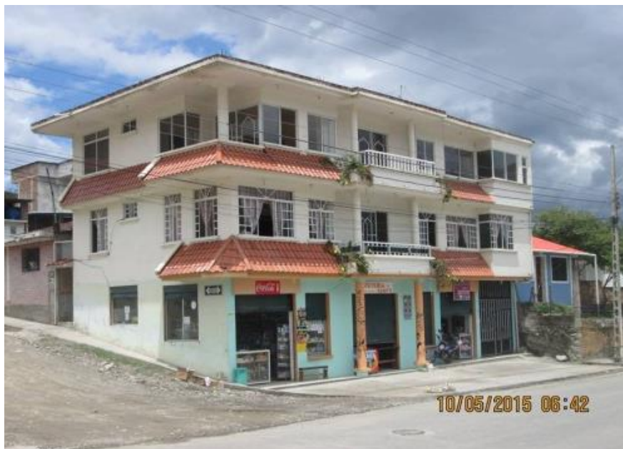
Imagen 46. Vivienda construida con hormigón armado y ladrillo
