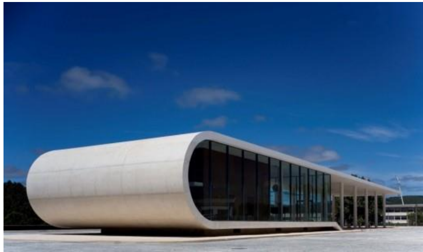
Imagen 28. Vista principal de la estación
