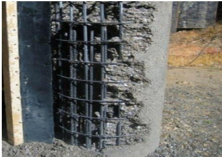
Imagen 13. Columna cilíndrica de hormigón armado
