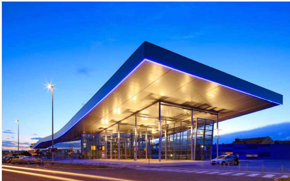
Imagen 31. Terminal de Buses Osijek, Croacia
