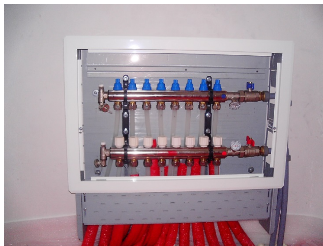
Imagen 27. Colector para suelo radiante
