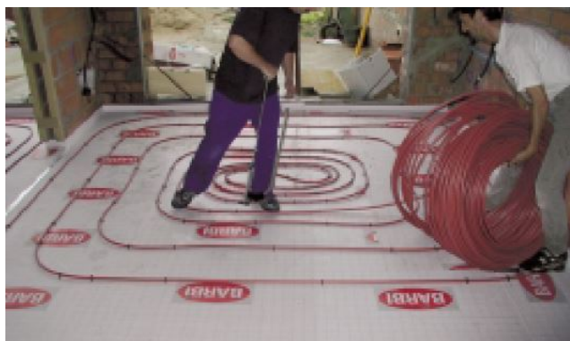
Imagen 29. Distribución de la tubería
