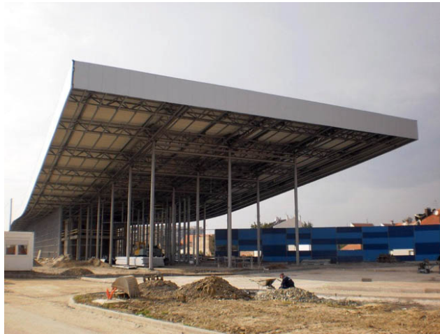
Imagen 34. Columnas y estructura de acero
