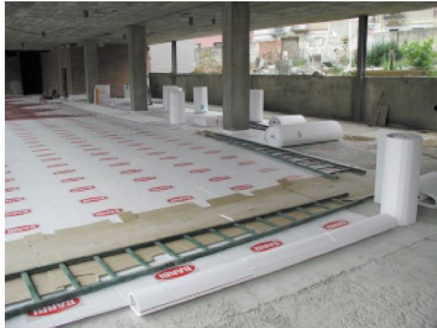
Imagen 28. Colocación panel aislante y banda perimetral.
