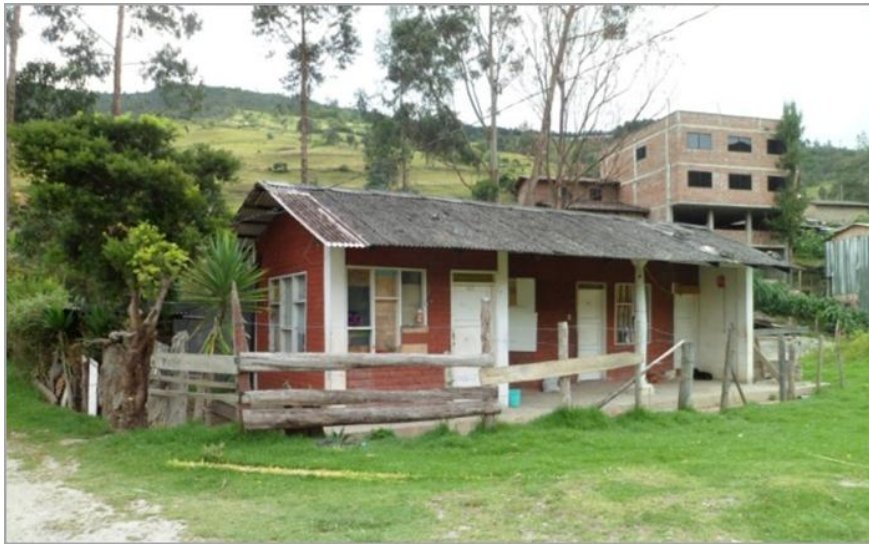
Figura 27. Edificación aledaña al terreno
