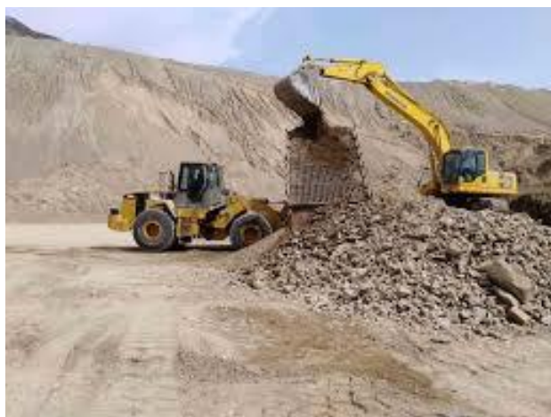
Figura 13. Extracción de Escombros.
